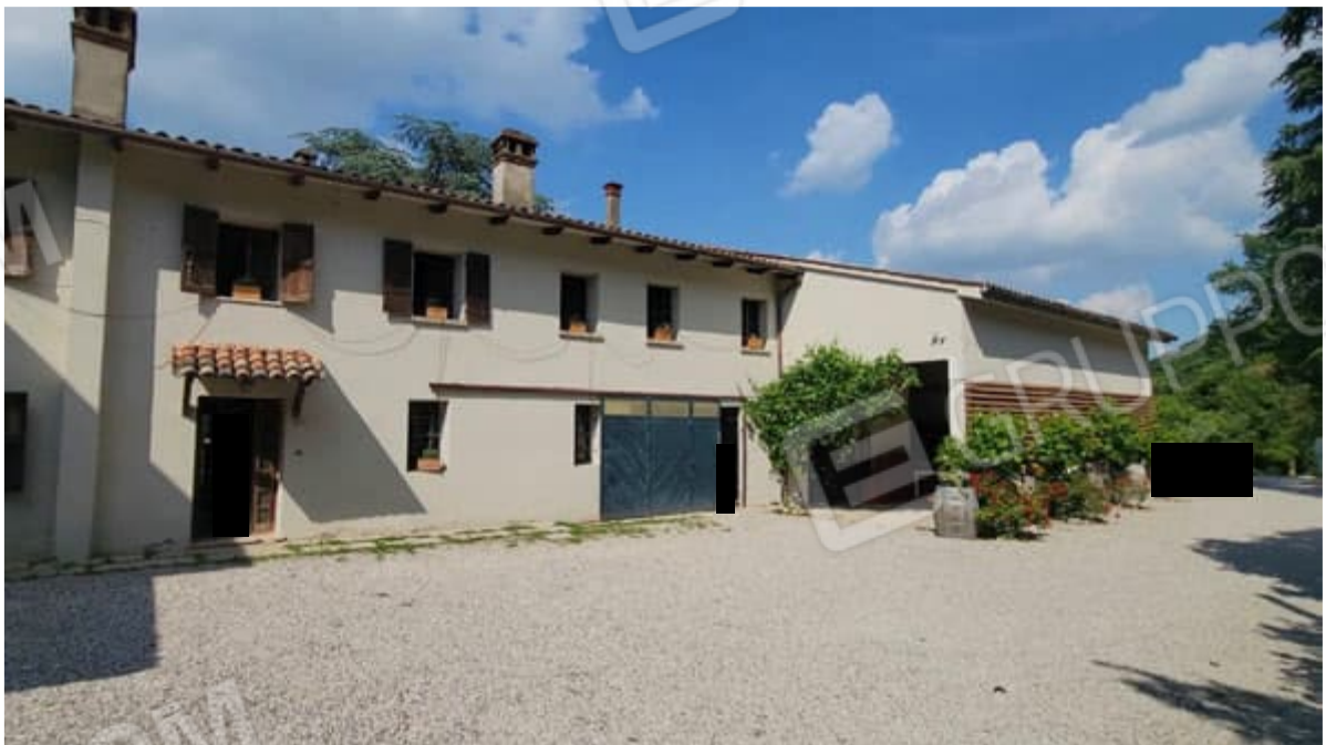
Figura 3 Esterno lato Sud
