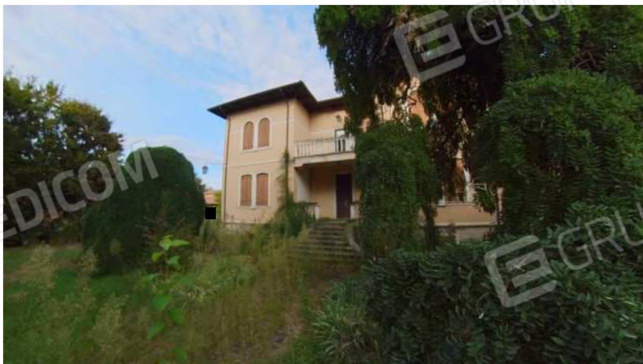
Figura 7 FACCIATA PRINCIPALE DELLA VILLA
