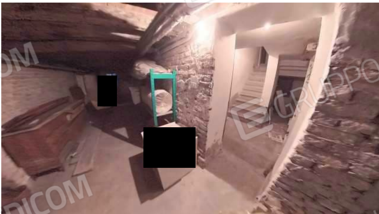
Figura 61 CANTINE AL PIANO SEMINTERRATO
