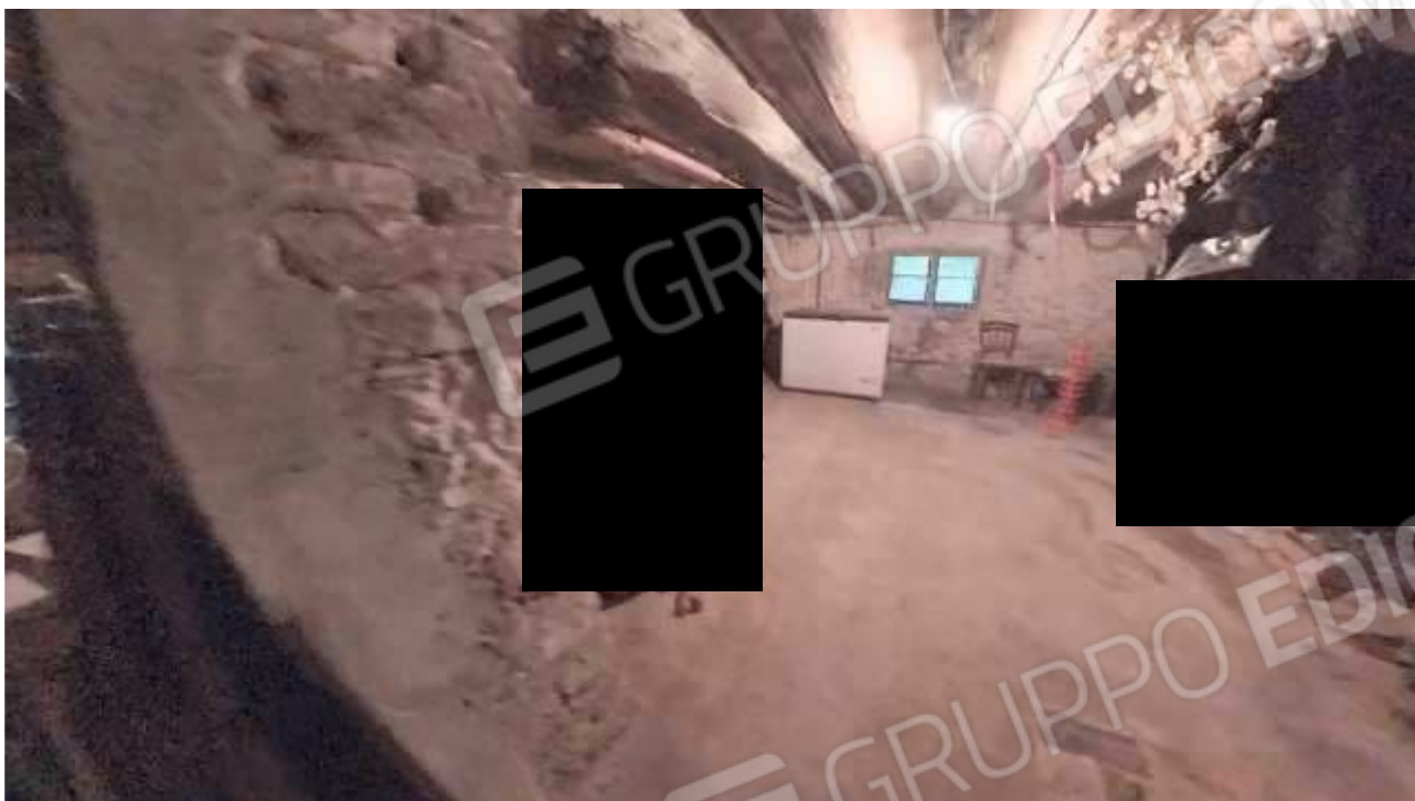
Figura 58 CANTINE AL PIANO SEMINTERRATO
