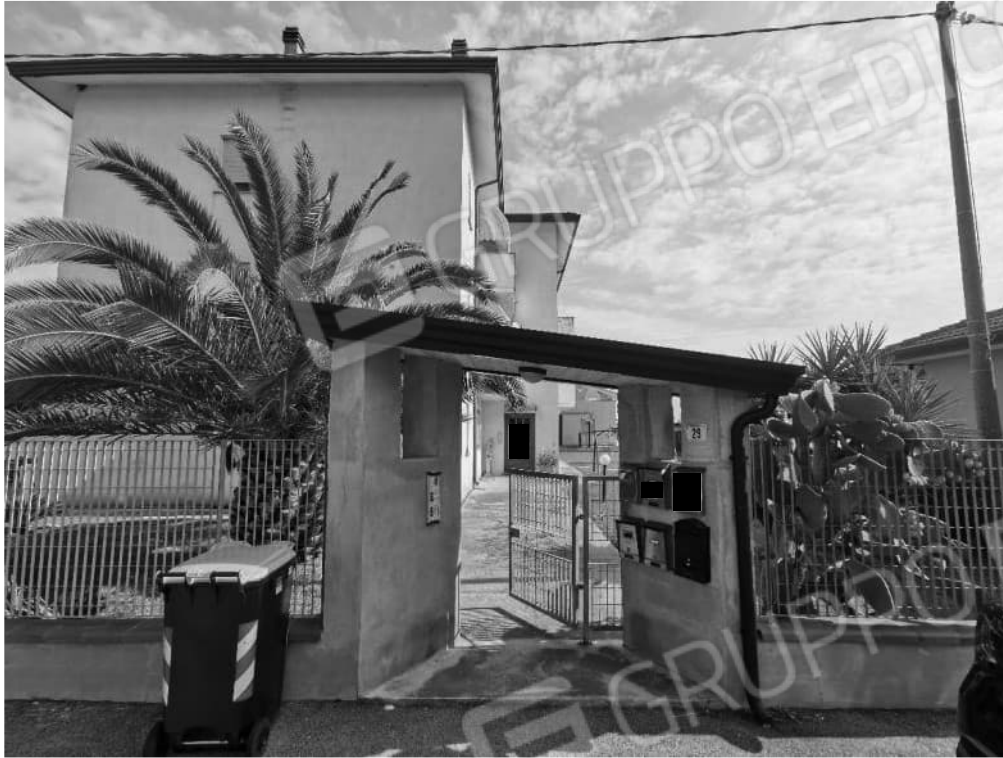
FOTOGRAFIA N.1 - ingresso condominiale esterno
