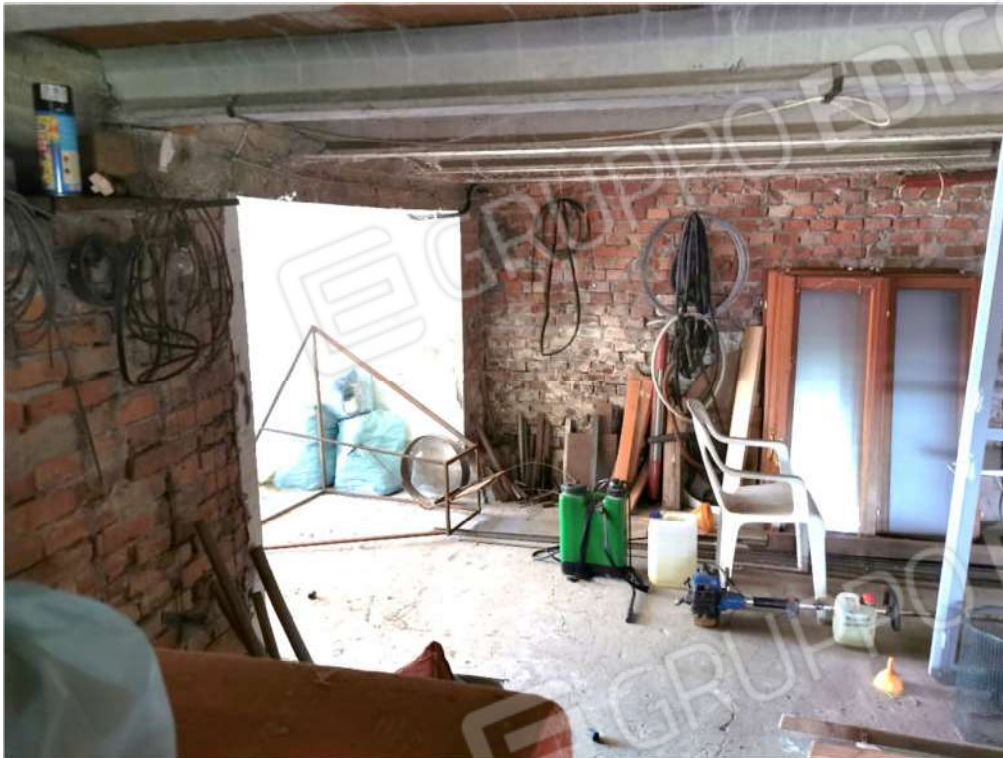
FOTOGRAFIA N.13 - particolare interno locali sottostanti il negozio
