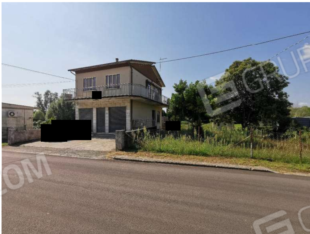
FOTOGRAFIA N.2 - particolare prospetto principale
