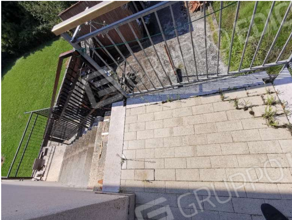
FOTOGRAFIA N.11 - particolare scala esterna e poggiolo
