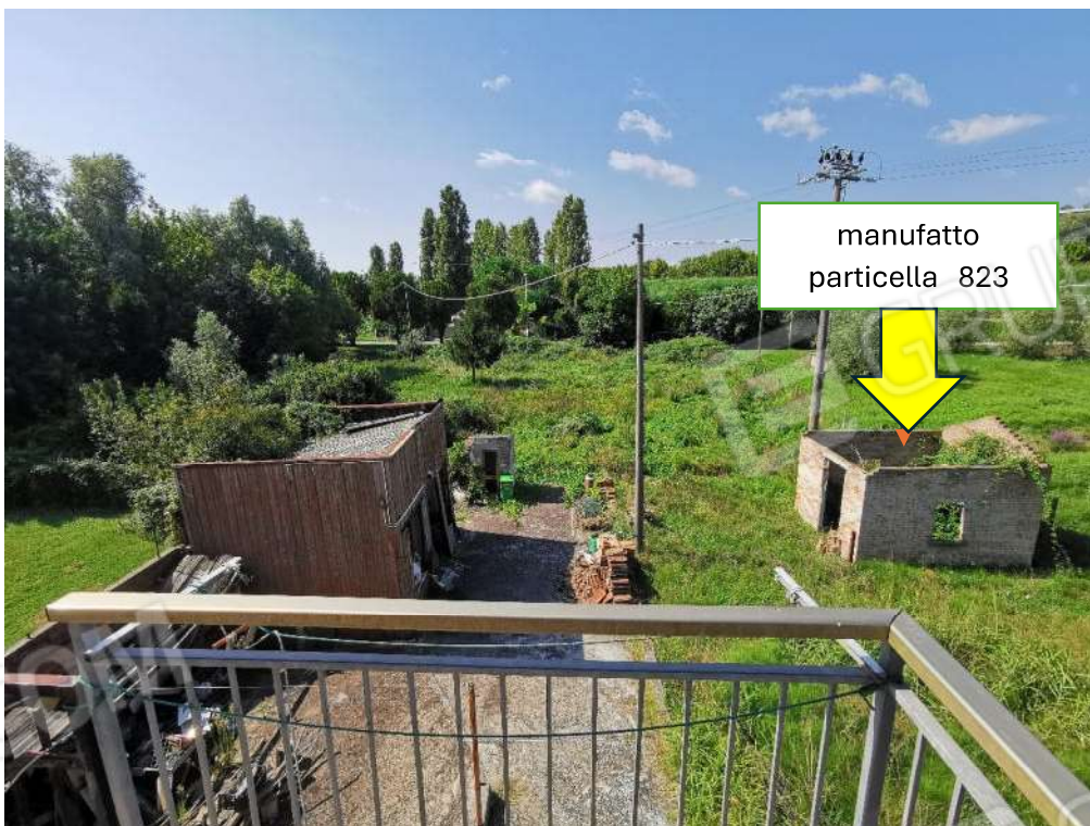
FOTOGRAFIA N.14 - particolare area pertinenziale con manufatti sovrastanti
