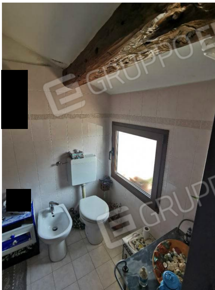
9 – PARTICOLARE INTERNO PIANO PRIMO
