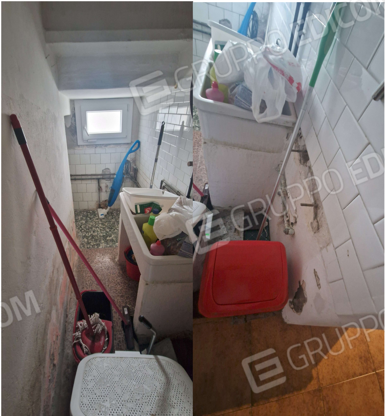
Particolare del sottoscala
