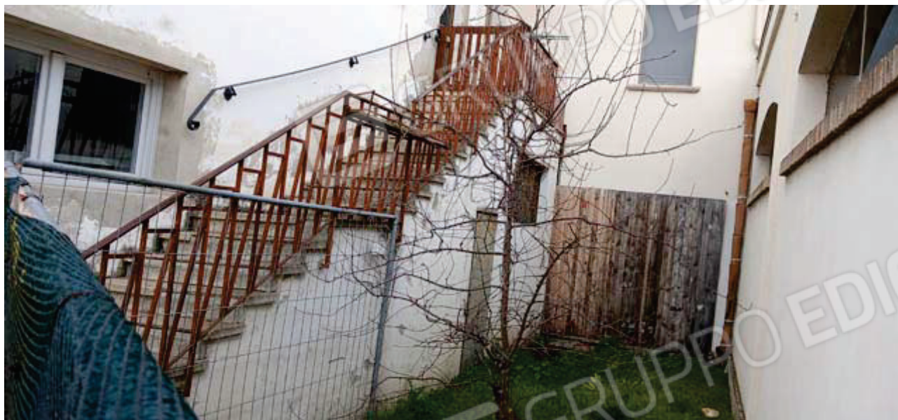
FOTO 03 - SCALA ESTERNA FRONTE SUD
