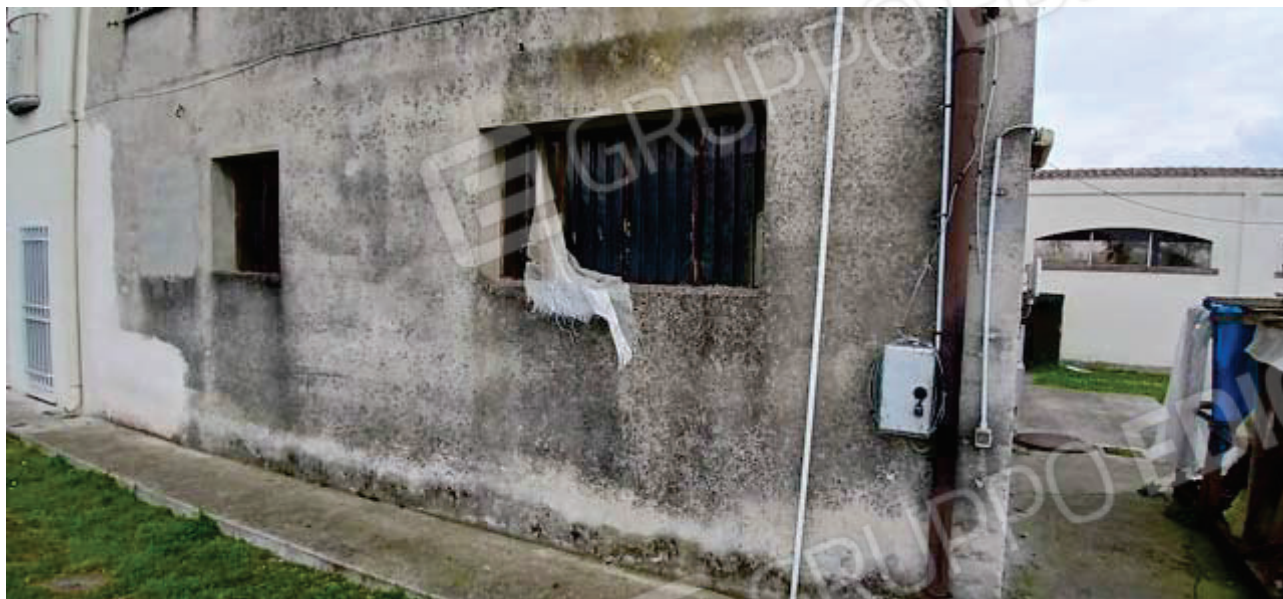
MAGAZZINI (MN. 697 SUB. 7) ESTERNO FOTO 08 - FRONTE NORD
