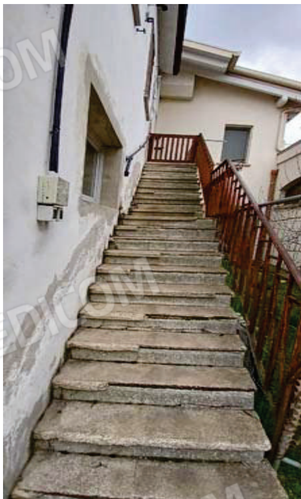
FOTO 04 - SCALA ESTERNA VISTA DA OVEST
