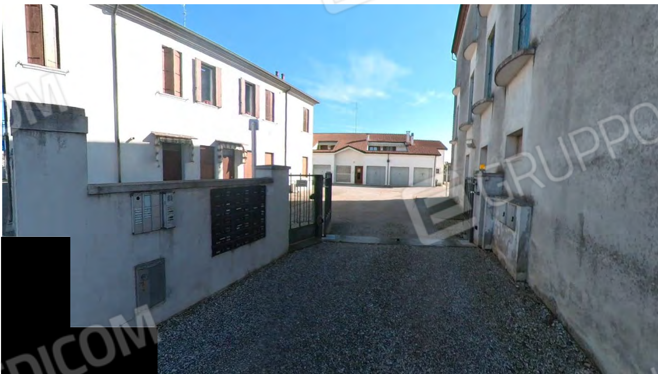
Figura 5 passaggio attraverso il cortile del condominio insistente sul mn 123, fg 7 lato strada
