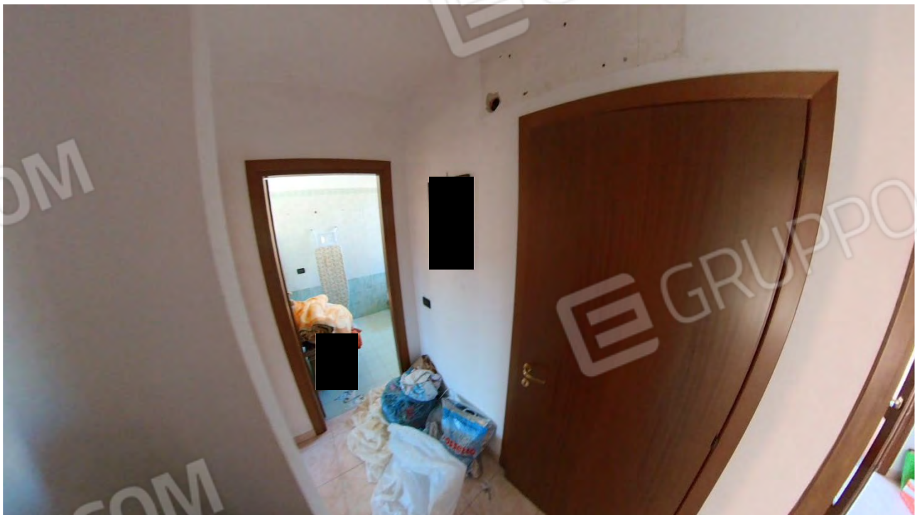
Figura 14 interni abitazione primo piano
