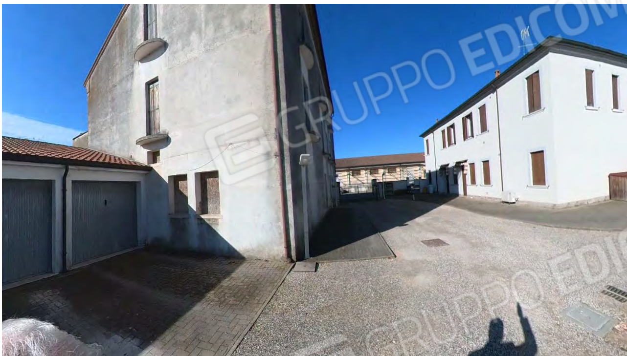
Figura 4 passaggio attraverso il cortile del condominio insistente sul mn 123, fg 7
