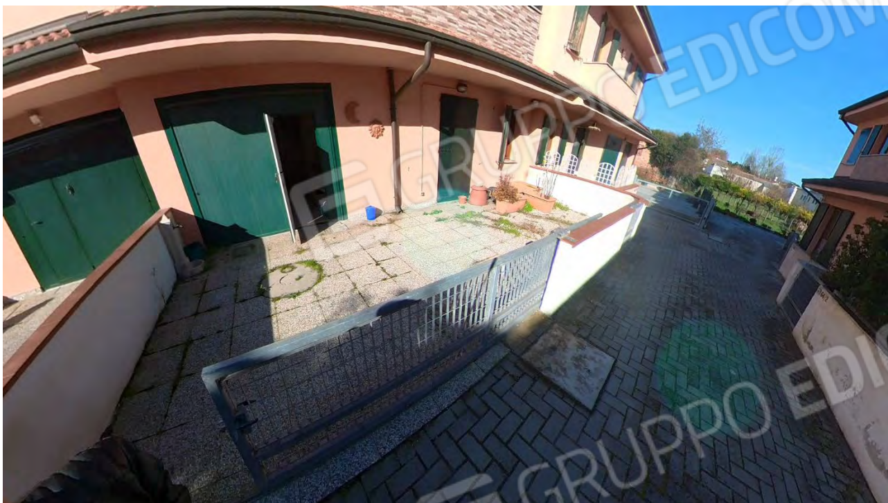
Figura 8 veduta esterna abitazione pignorata e stradello comune di
