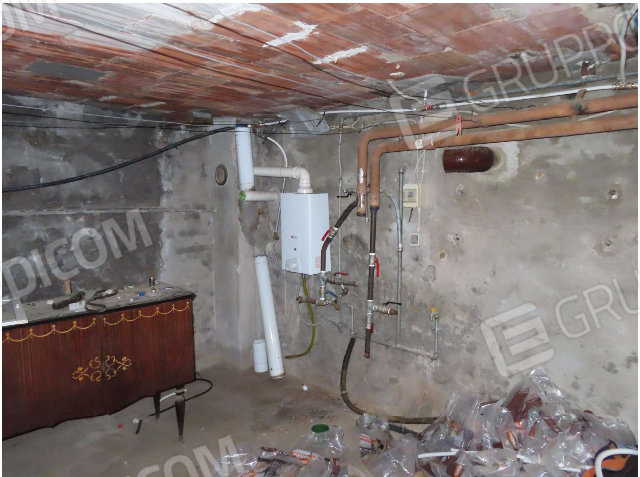
RIPOSTIGLIO LATO CALDAIA ed ISTANTANEO PER ACQUA SANITARIA
