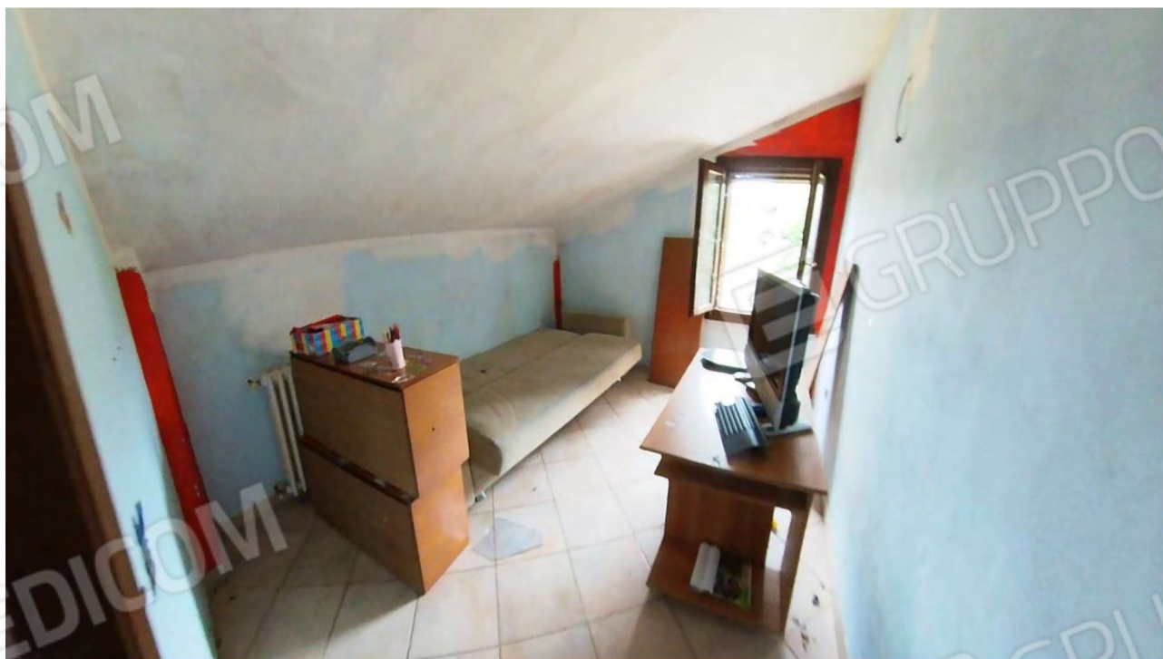
Figura 21 Interni primo piano (sottotetto Nord)
