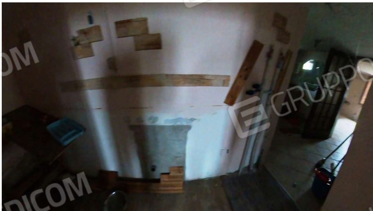
Figura 11 Interni piano terra
