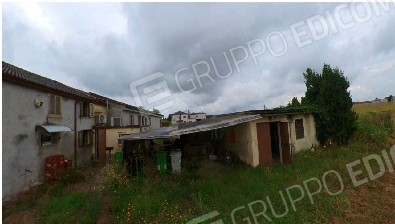
Figura 6 Veduta pertinenza esterna e baracca da rimuovere
