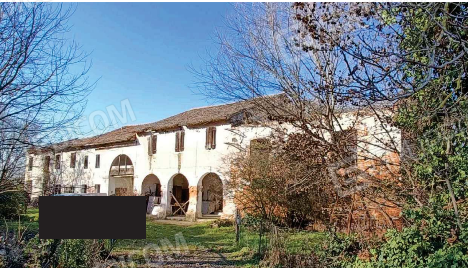
Foto 02 – prospetto sud fabbricato principale
