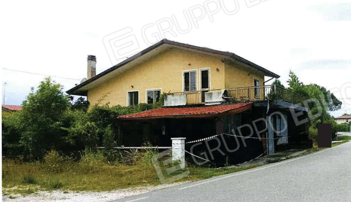
Foto n. 1- Prospetto Nord Est da via Calstorta
