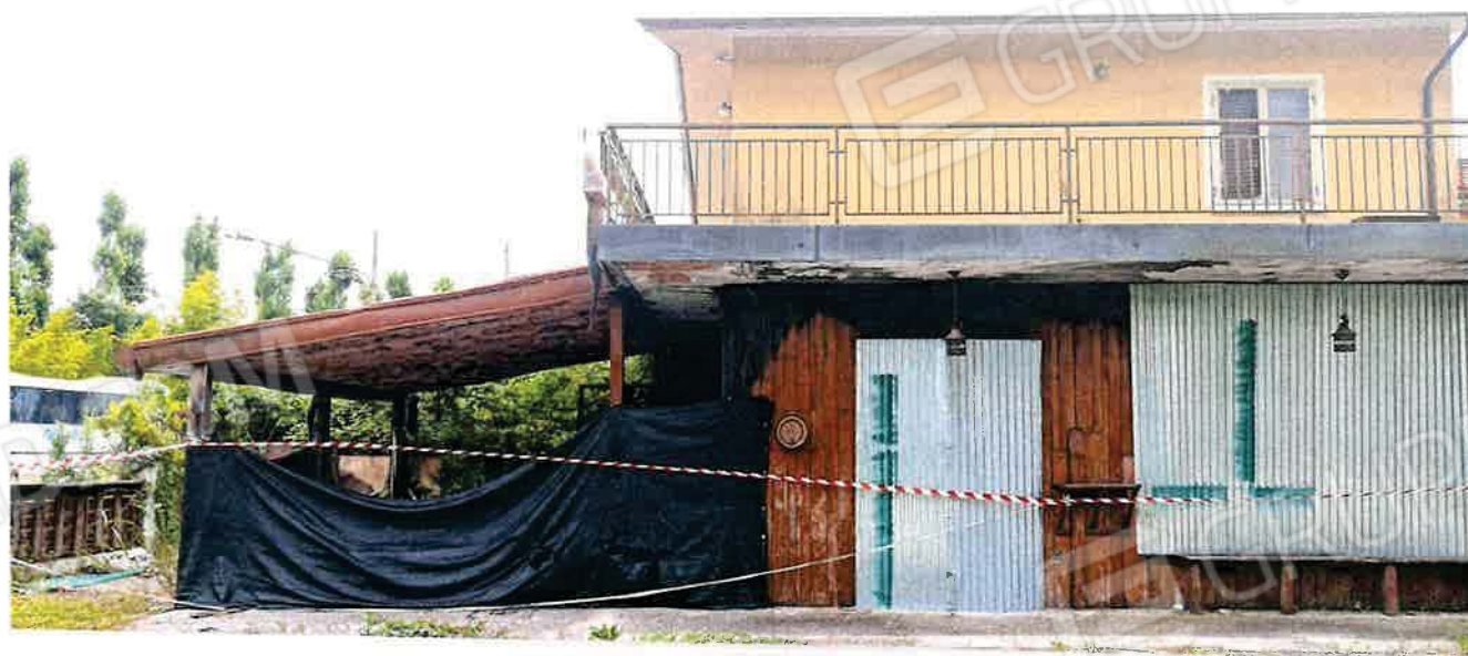
Foto n. 2- Prospetto Nord Est da via Calstorta
