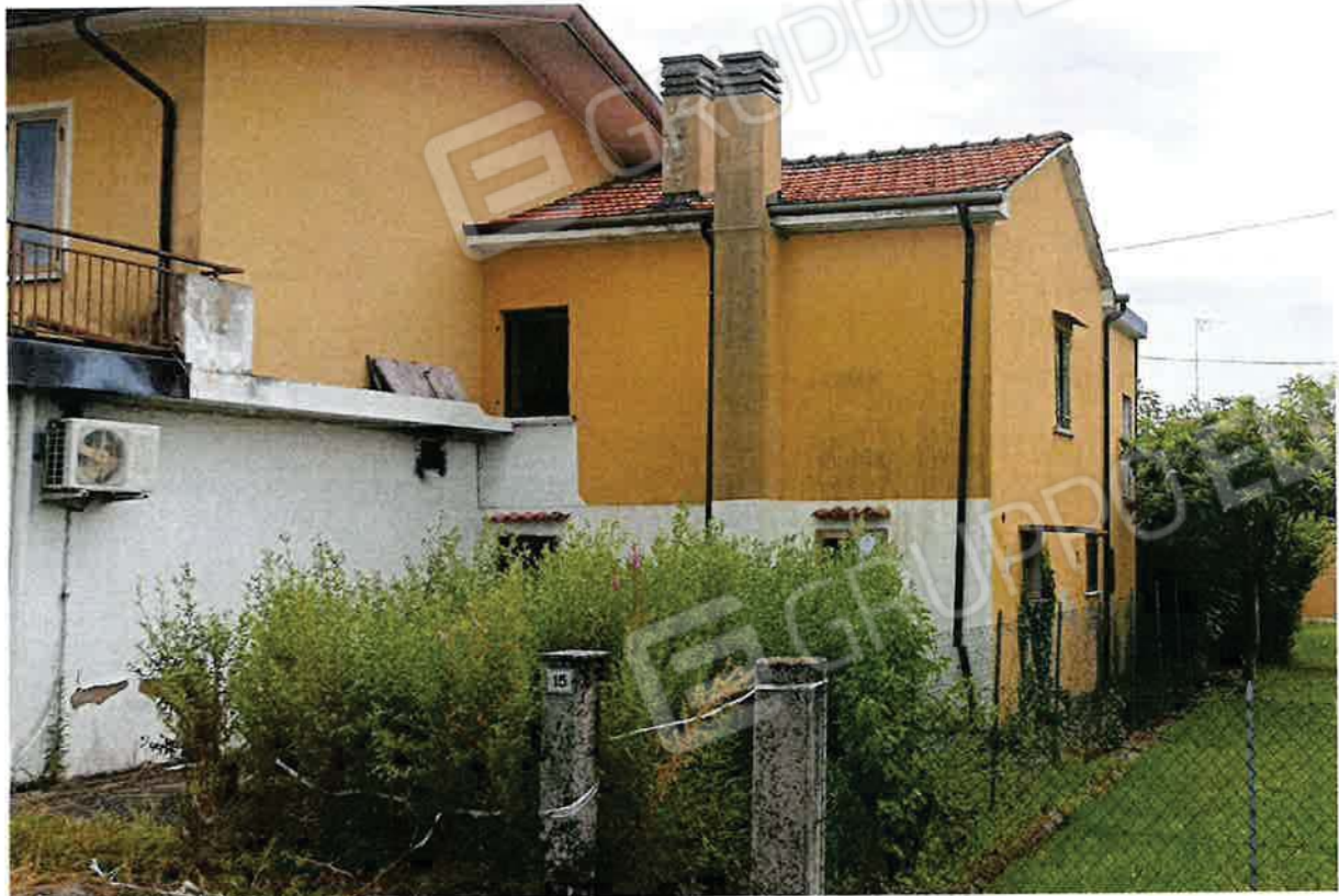
Foto n. 11 prospetto Nord Ovest sub 6 sub 7
