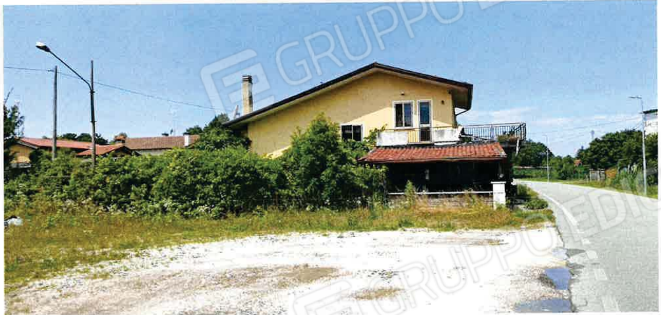
Foto n. 3- Prospetto Est dal parcheggio (Sub 8)
