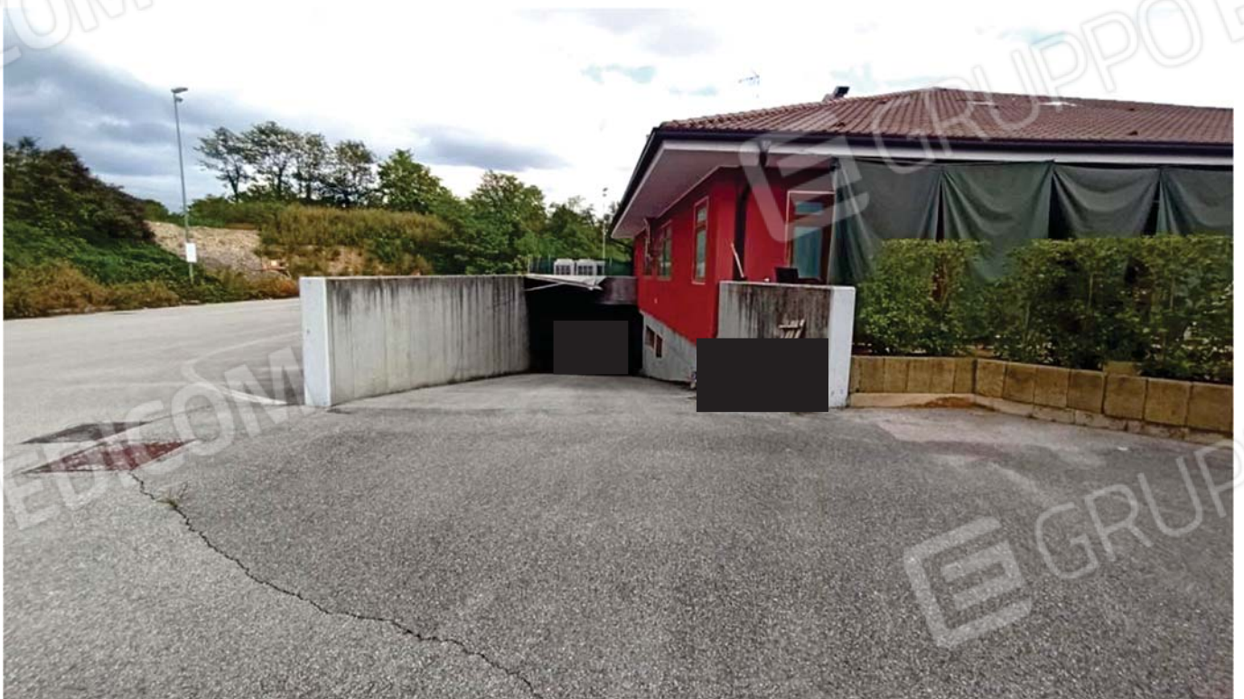
Accesso carrabile piano interrato
