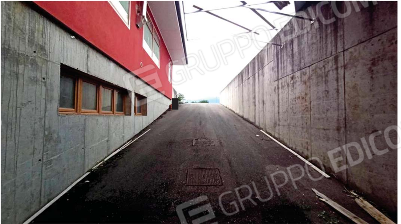
Rampa di accesso interrato
