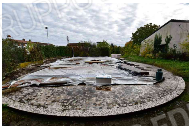
2. Vista verso est.
