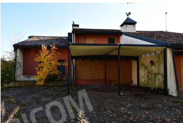
5. Prospetto ovest, pompeiana (1 di 2).
