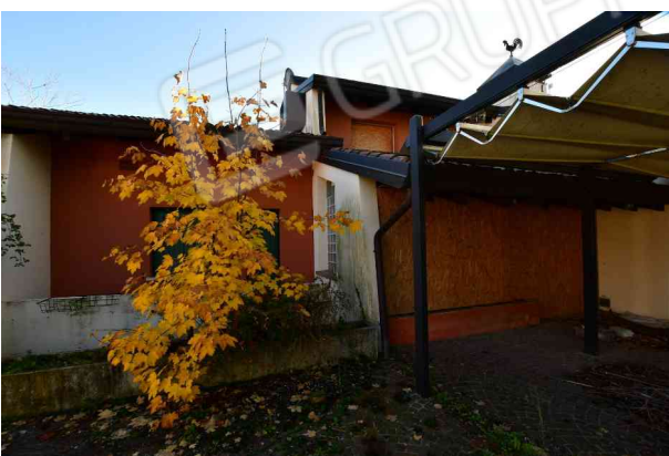
6. Prospetto ovest, pompeiana (1 di 2).
