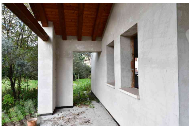
3. Portico, vista verso ovest.
