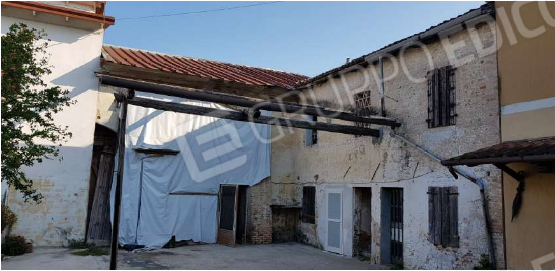
Fabbricato A - lato sud
