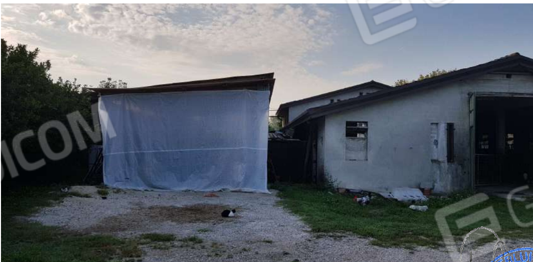
Fabbricato C - lato nord
