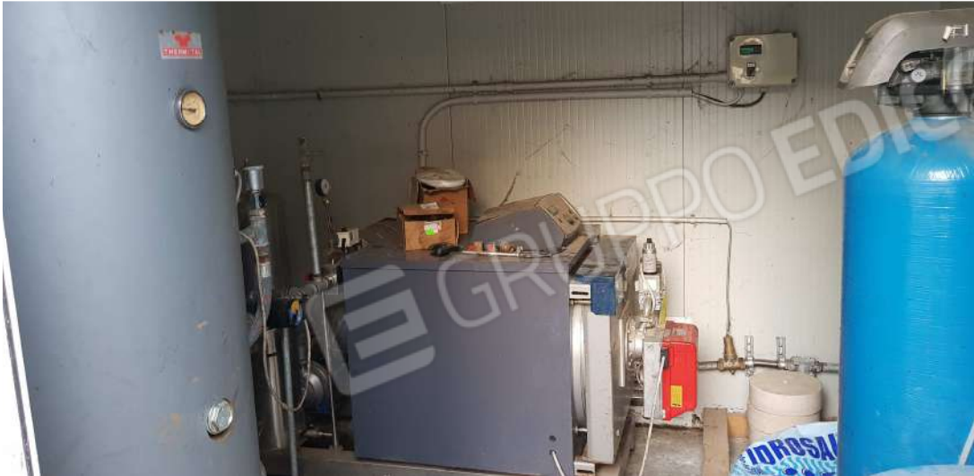
Fabbricato D - minicaseificio centrale termica
