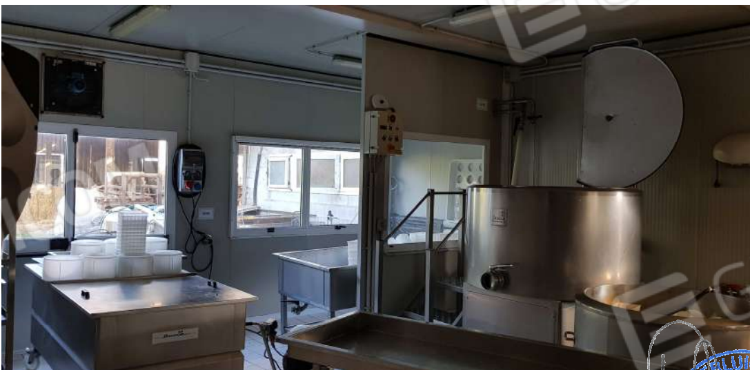
Fabbricato D - minicaseificio piano terra
