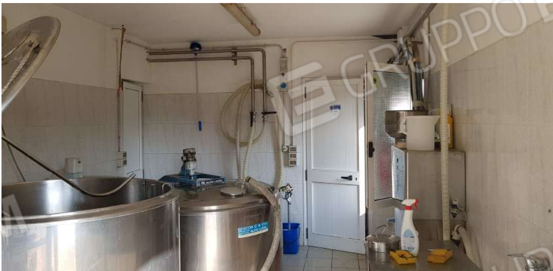
Fabbricato D - locali accessori lavorazione del latte
