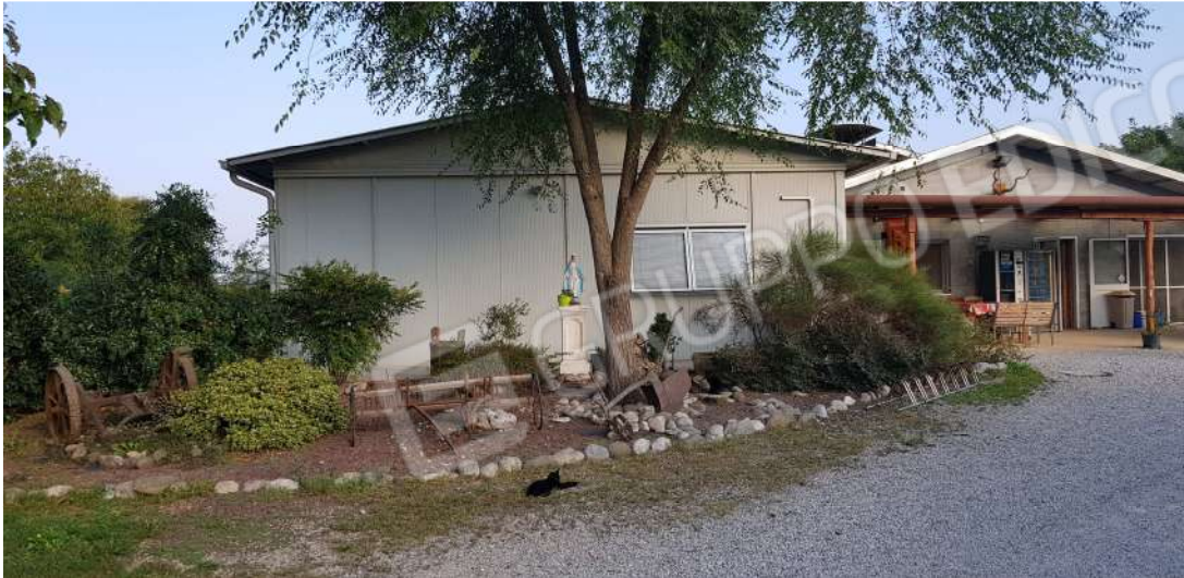
Fabbricato D - minicaseificio lato sud
