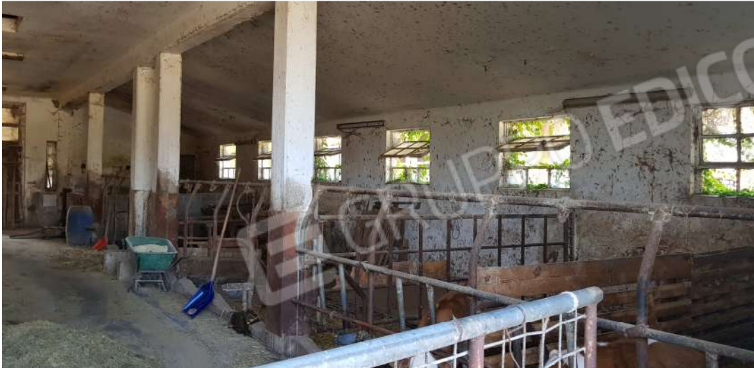
Fabbricato B - piano terra
