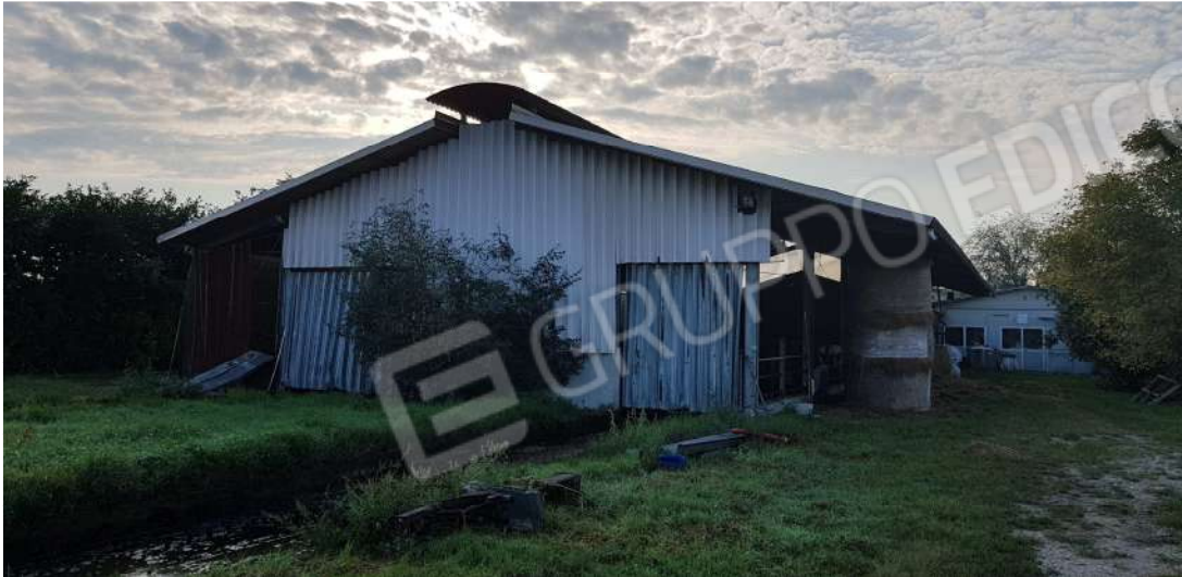
Fabbricato D - stalla lato nord
