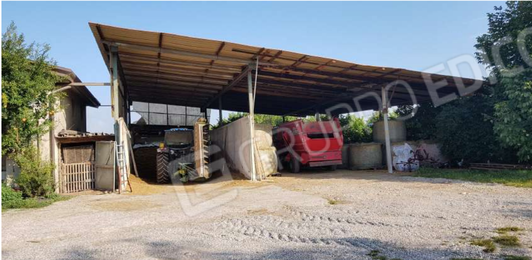
Fabbricato C - lato sud piano terra
