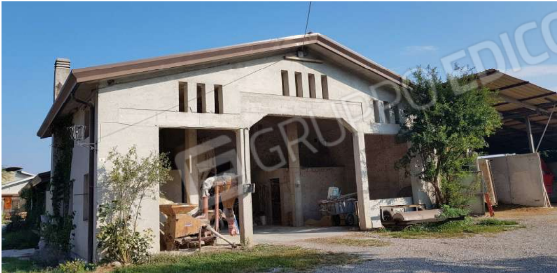
Fabbricato B - lato sud
