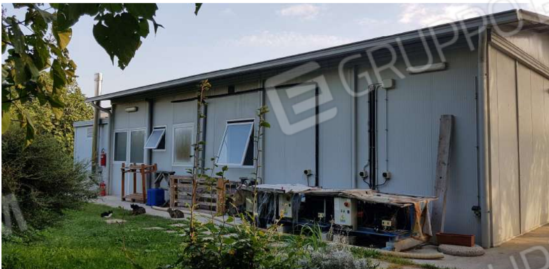
Fabbricato D - minicaseificio lato ovest
