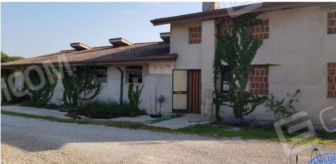
Fabbricato B - lato ovest
