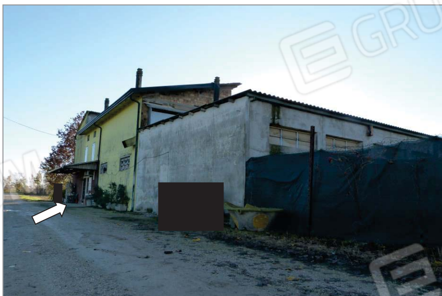
2 Vista da nord-ovest di parte dei fabbricati del complesso agricolo. La freccia indica l'accesso al reparto vendita al dettaglio.
