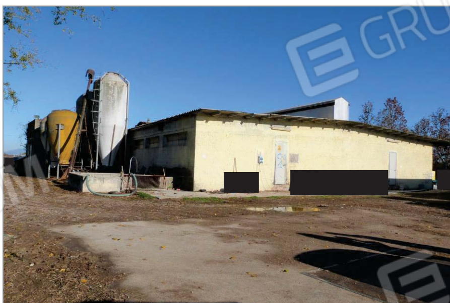
4 Vista del prospetto sud e di parte del prospetto ovest del capannone ad uso allevamento.
