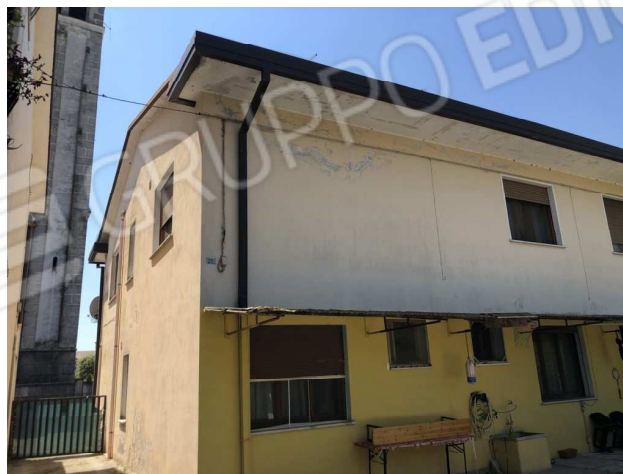
foto 4 vista esterna da nord-est
