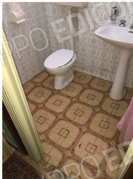
foto 16 bagno camera a nord-est
