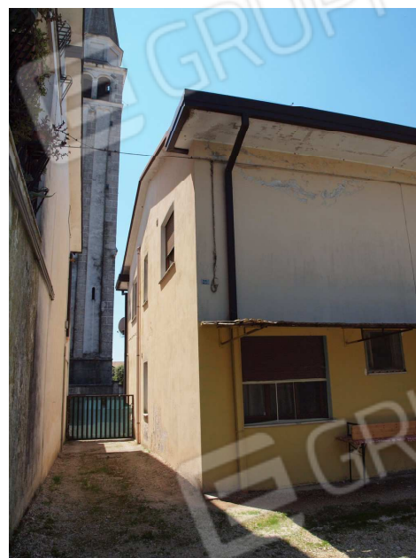
foto 6 vista esterna ingresso carraio (da nord)
