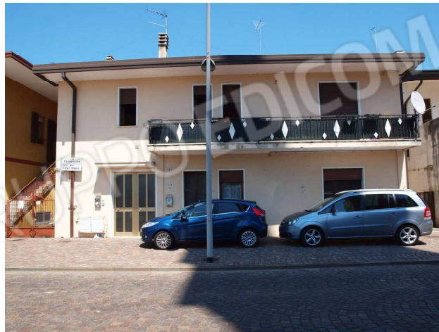
foto 2 vista esterna da sud
