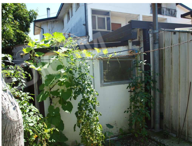
foto 23 magazzino retrostante ai garage
