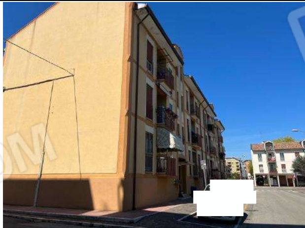
Vista esterna – Prospetto laterale edificio
