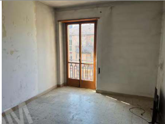
Vista Interna – Camera lato Ovest
