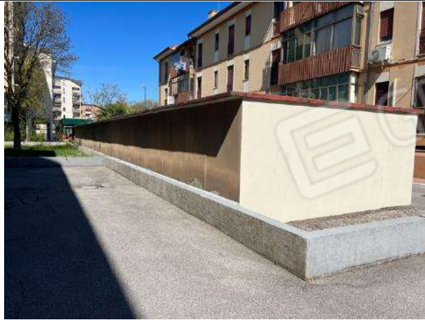
Vista esterna – Fabbricato Garage
