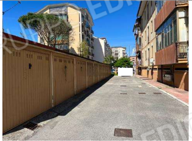
Vista esterna – Fabbricato Garage
