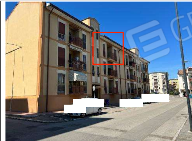
Vista esterna – Prospetto principale su via Toscana
