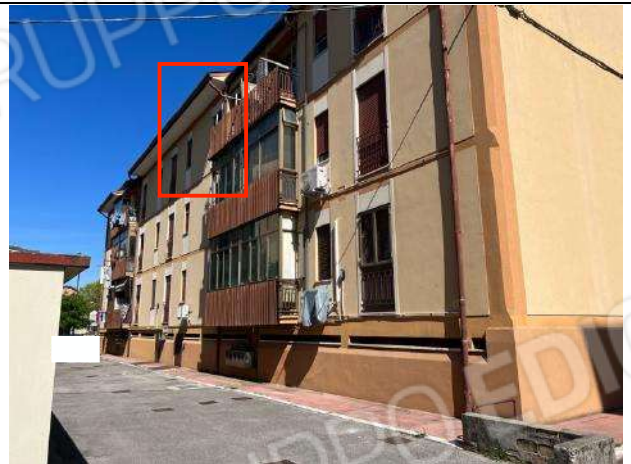
Vista esterna – Prospetto retro edificio
