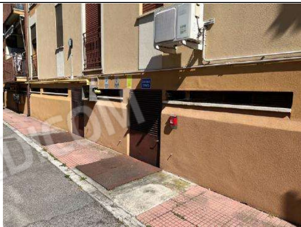
Vista esterna – Prospetto retro-zona Centrale termica condominiale
