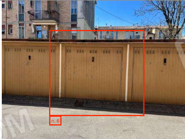
Vista esterna – Garage
