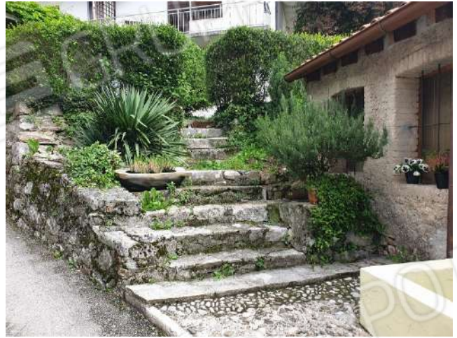
foto n. 16 – accesso pedonale da via Sottocroda
