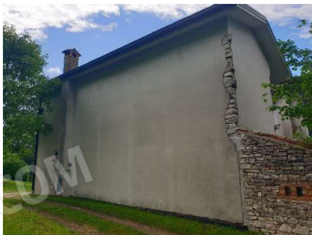
foto n. 3 – fronti nord e ovest dell'abitazione
