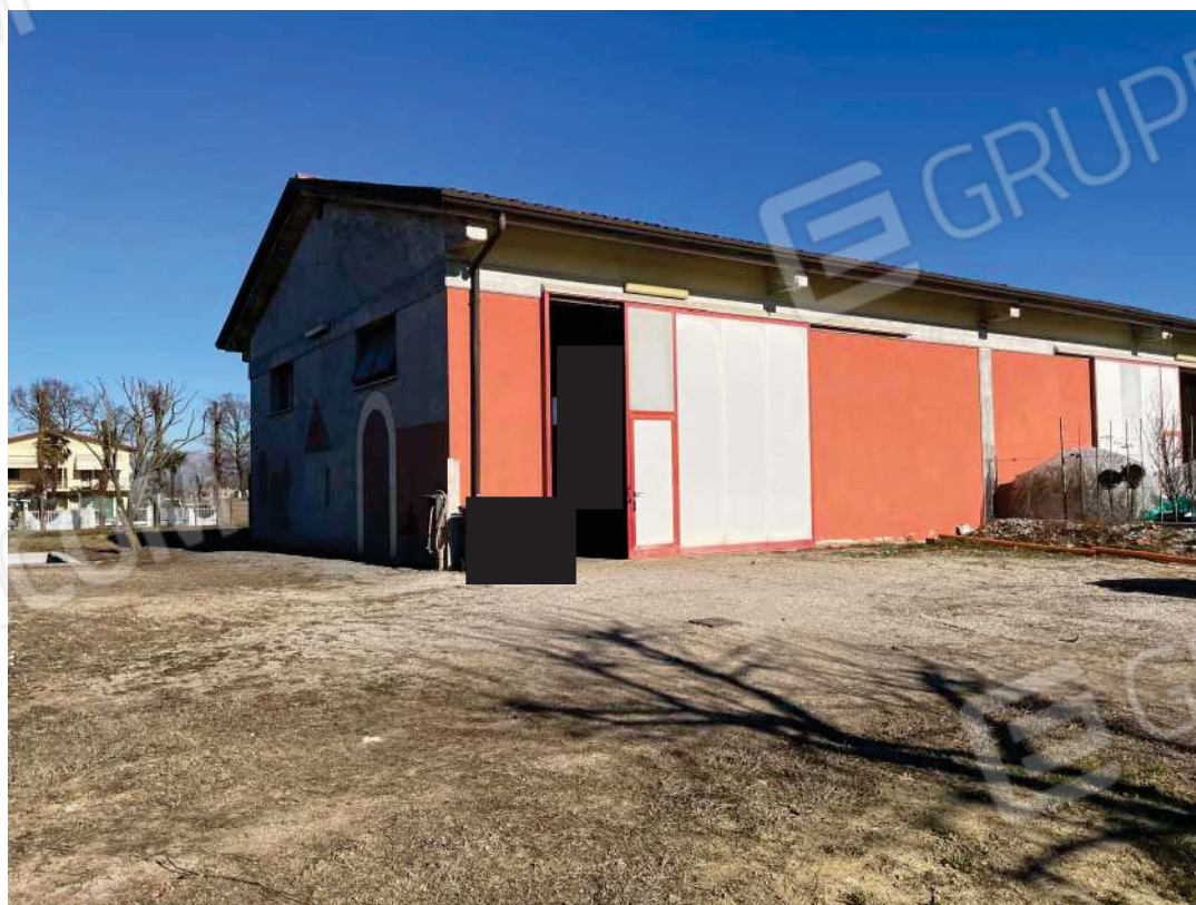
Particolare esterno magazzino deposito attrezzi
