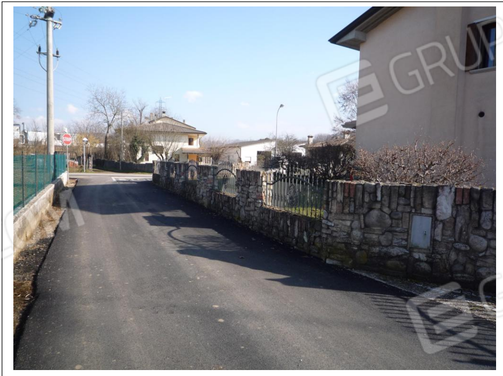
Vista recinzione lato Via Gorizia
