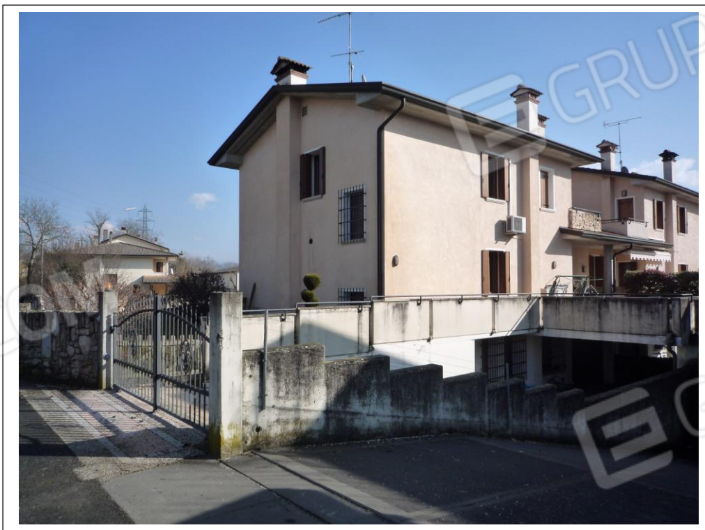
Vista a Nord-Ovest con accesso carraio della rampa Garage
