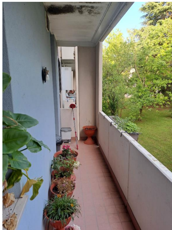
FOTO N°10. - visione interna PIANO PRIMO
