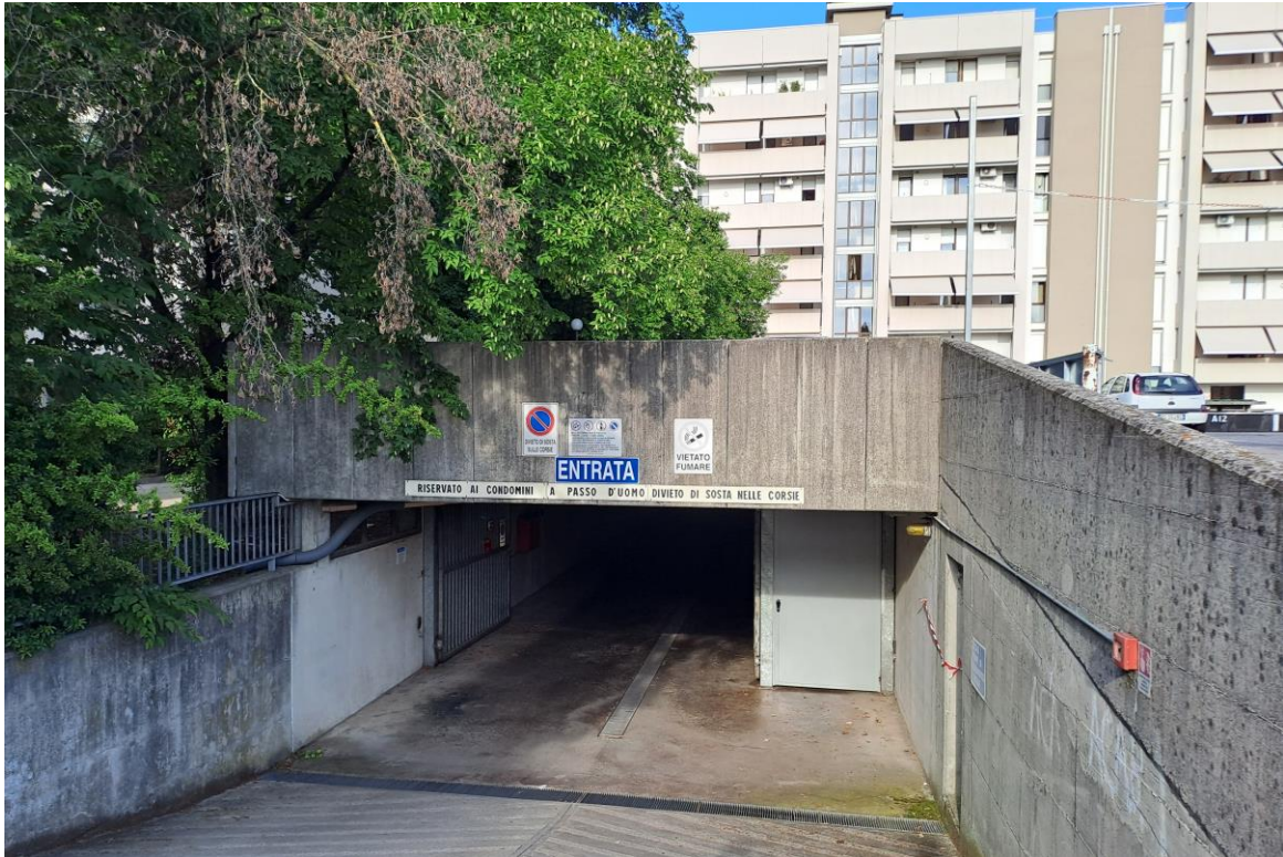
FOTO N°11. - visione ACCESSO PIANO INTERRATO
