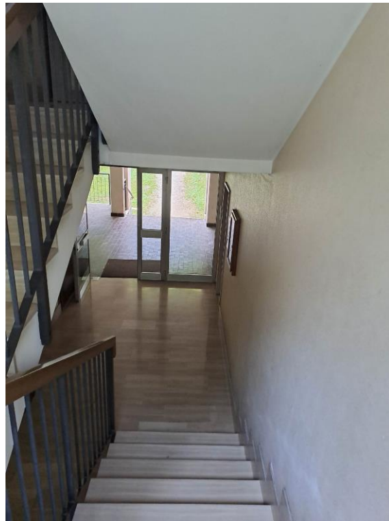
FOTO N°4. - visione vano scala condominiale
