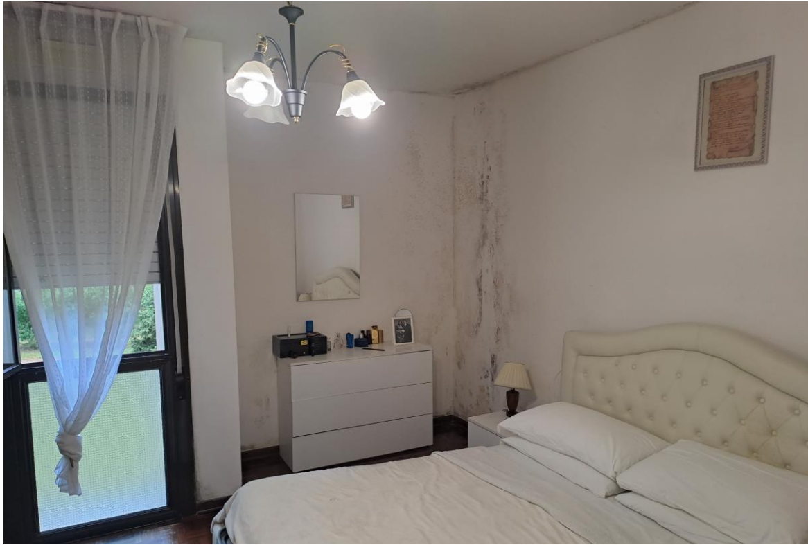
FOTO N°5. - visione interna PIANO PRIMO
