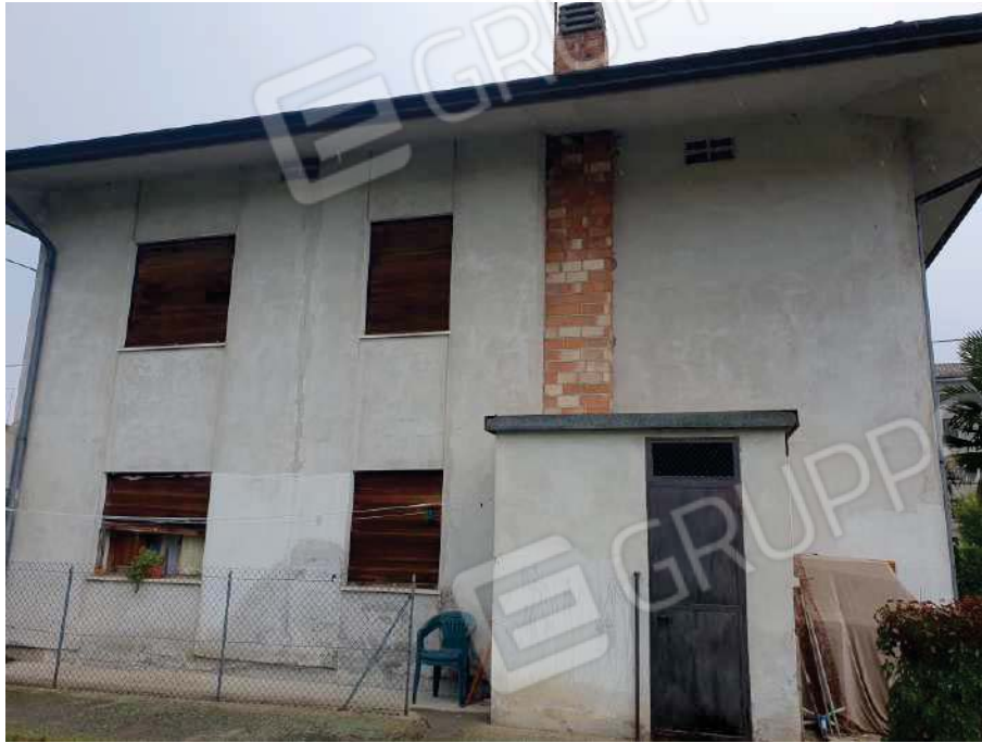
FOTO 18: vista immobile ovest
