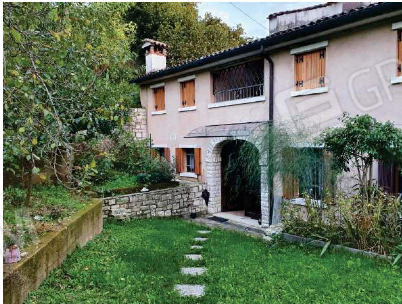
FOTO 6: vista fabbricato lato nord
