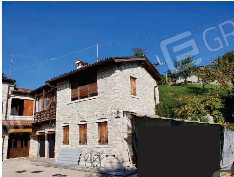
FOTO 2 : vista fabbricato lato sud
