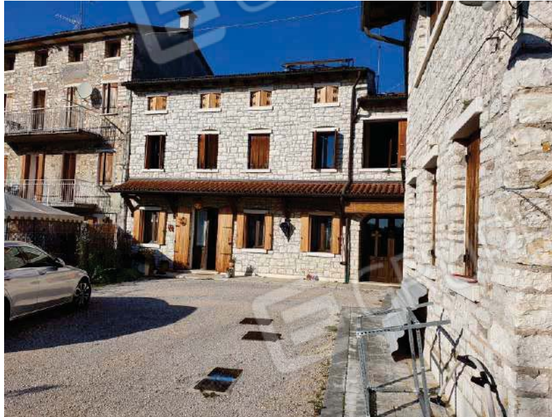
FOTO 1 : vista fabbricato lato sud
