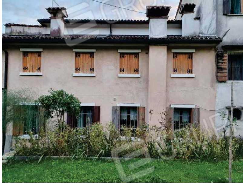
FOTO 5: vista fabbricato lato nord
