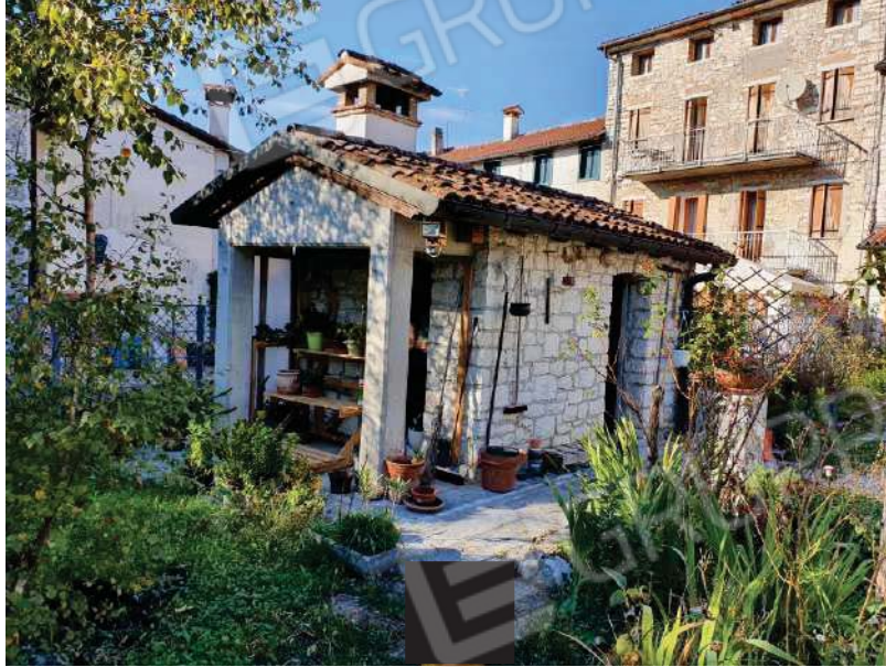
FOTO 3: vista fabbricato esterno ripostiglio
