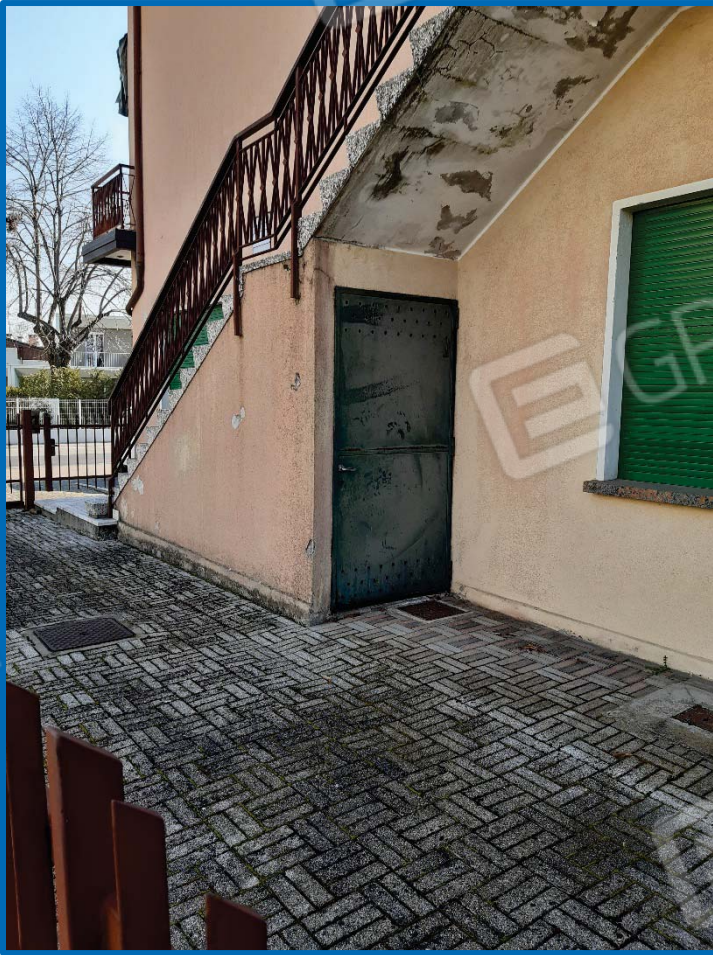
n° 3 Esterno – corte comune e ripost. sottoscala
