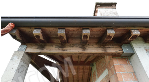
11. Vista struttura del portico (1 di 2).
