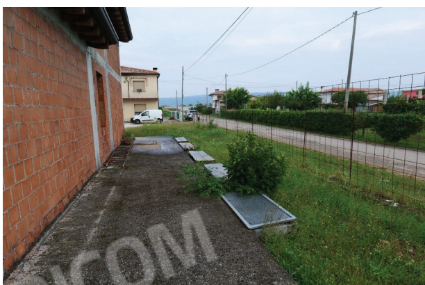
17. Vista verso nord, lato via Levada.
