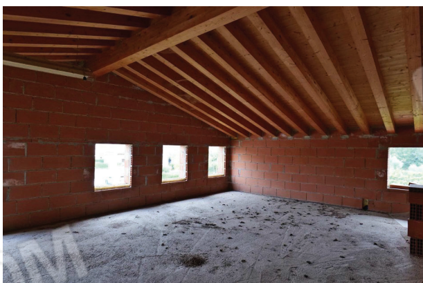
27. Piano primo sottotetto (1 di 5) - angolo nord est.
