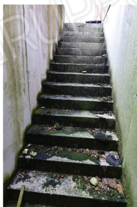
40. Piano interrato, scala esterna verso nord.
