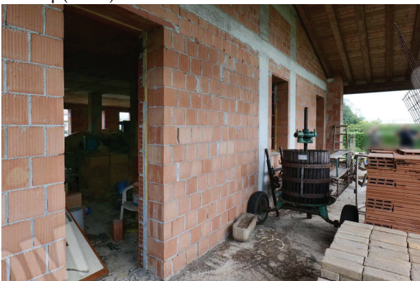
15. Piano terra, portico a sud.
