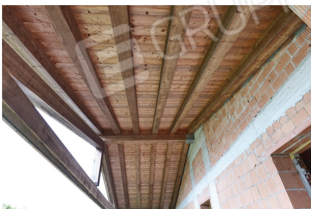
12. Vista struttura del portico (2 di 2).
