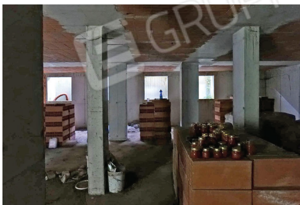
36. Piano interrato (3 di 6).
