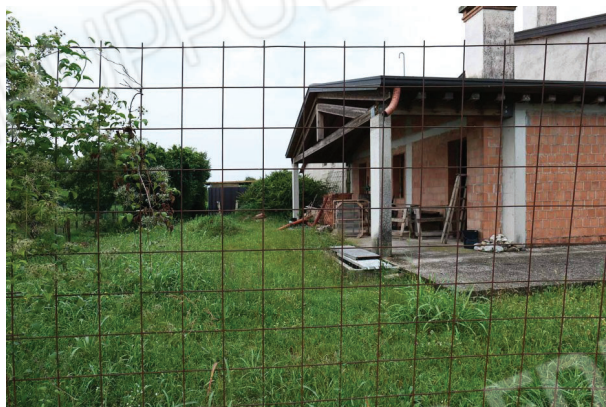
8. Vista portico abitazione a sud e B.C.N.C. sub. 14.
