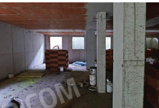
35. Piano interrato (2 di 6).
