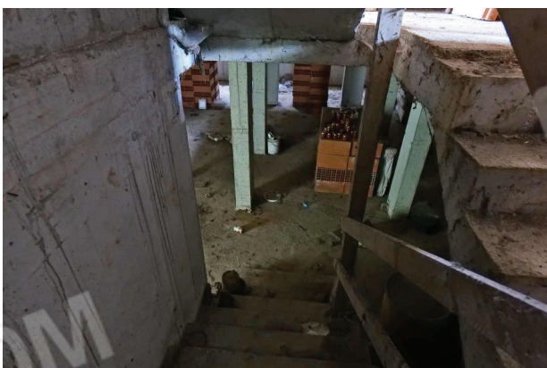
33. Piano interrato, discesa scala.
