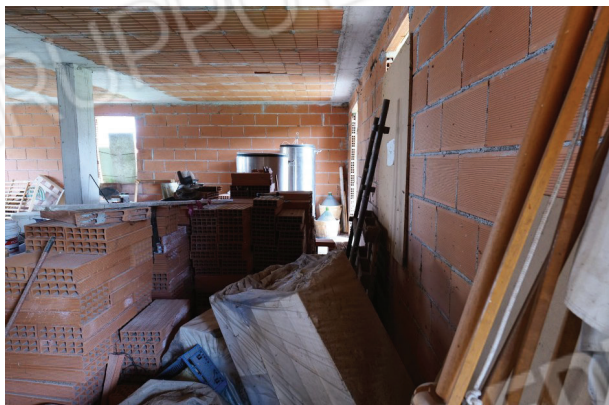
26. Piano terra (9 di 9).
