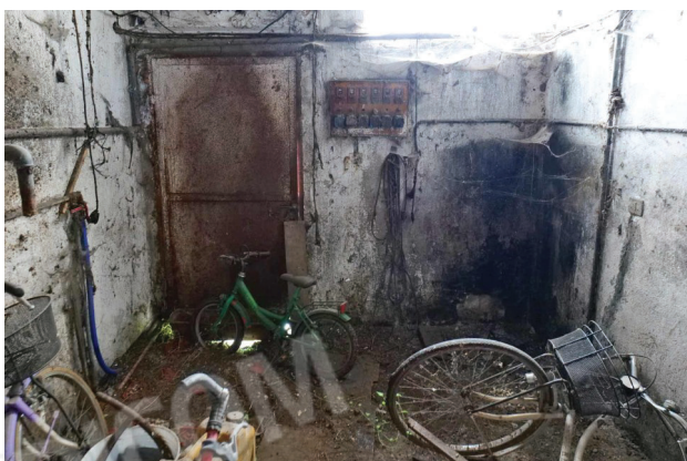
41. Piano terra - magazzino, ingresso (1 di 2).
