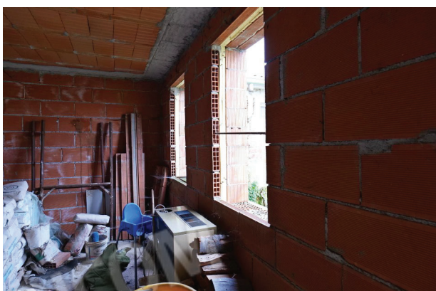
23. Piano terra (6 di 9).
