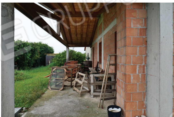
10. Vista del portico a sud.
