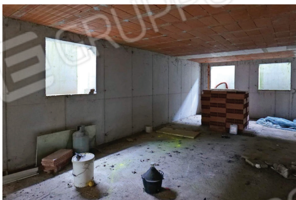
34. Piano interrato (1 di 6).
