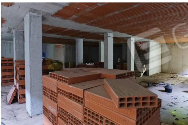
37. Piano interrato (4 di 6).
