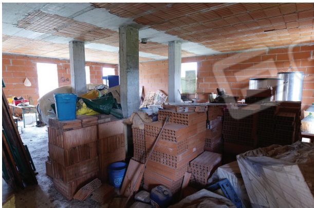
25. Piano terra (8 di 9).
