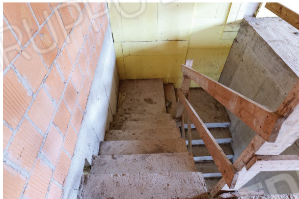
32. Piano terra, scala verso il piano interrato.
