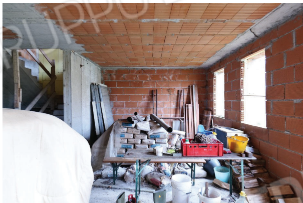
20. Piano terra (3 di 9).
