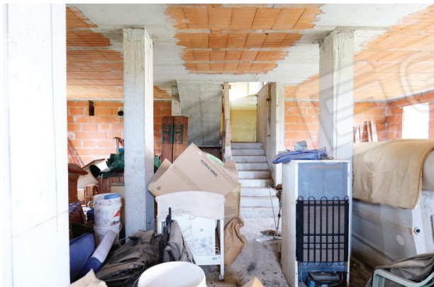
19. Piano terra (2 di 9).
