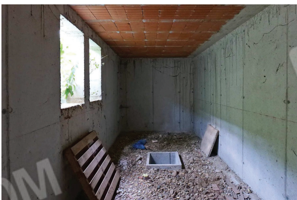
39. Piano interrato (6 di 6).
