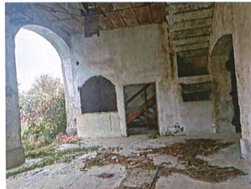
Foto n. 4-1 _ Documentazione fotografica parziale
