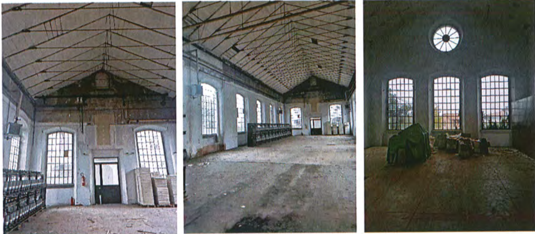
Foto n. 4-5 _ Documentazione fotografica parziale
