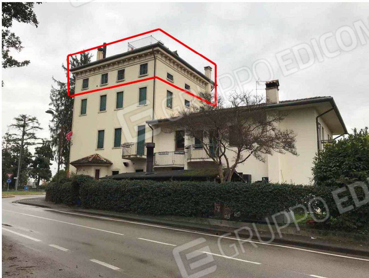
FOTO 2 - vista dal nord
