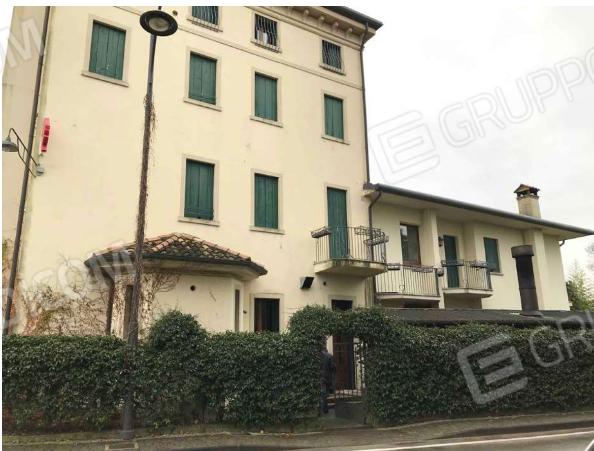
FOTO 3 - accesso pedonale lato nord
