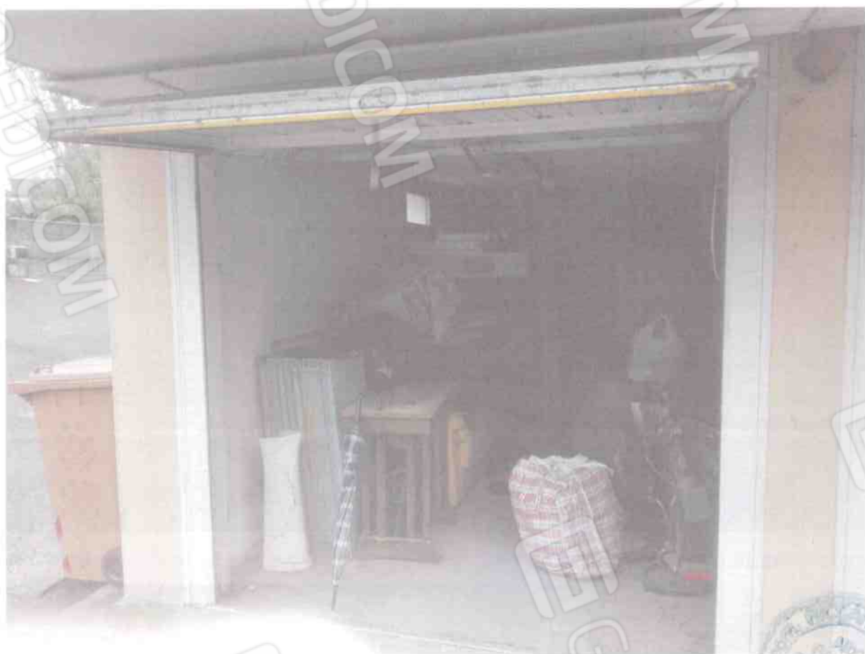
FOTO N°11 GARAGE DI PROPORIETA' VERSO INTERNO
