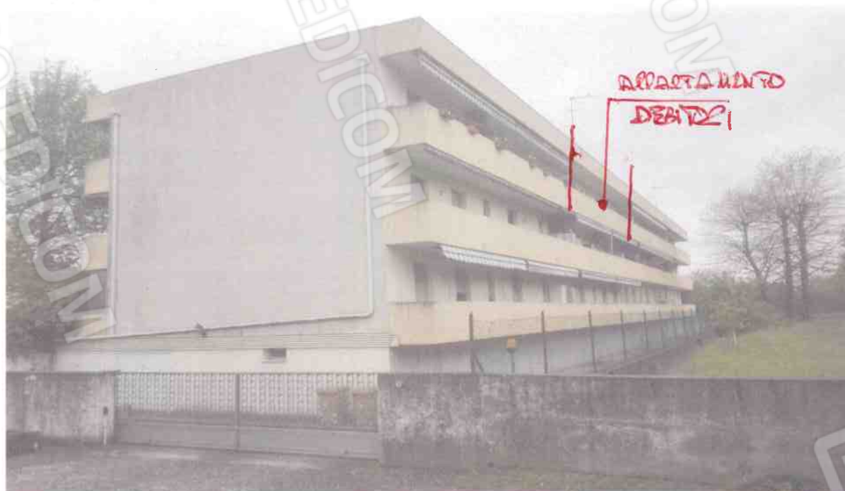
FOTO N°1 –LATO NORD DEL CONDOMINIO “ GRAZIA”
