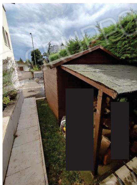
7 Casetta in legno lato Est
