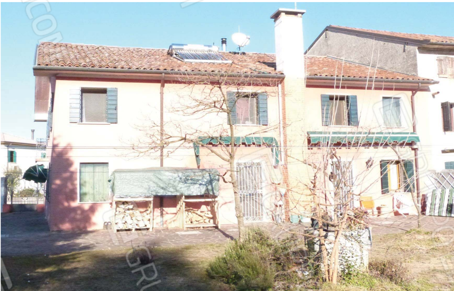
Vista del fronte sud.
