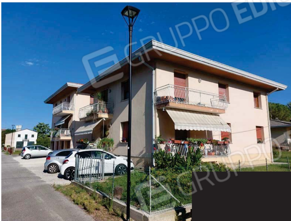
Foto n. 1: Prospetto nord-ovest del condominio "Riviera"
