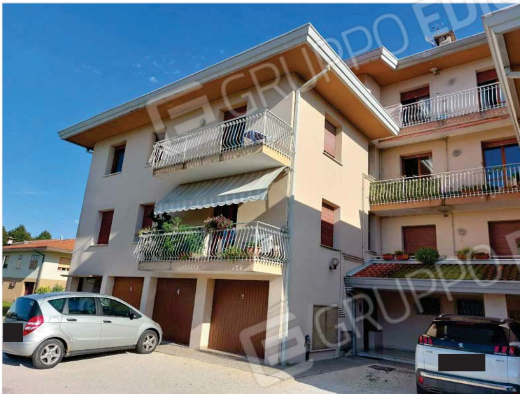
Foto n. 3: Prospetto nord del condominio "Riviera"
