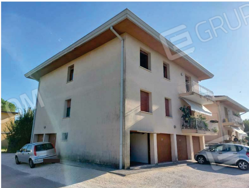
Foto n. 4: Prospetto nord-est del condominio "Riviera"
