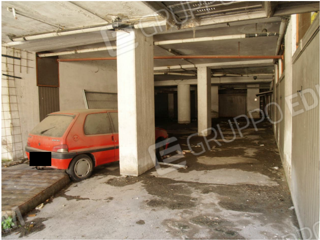
5. La corsia di manovra comune
