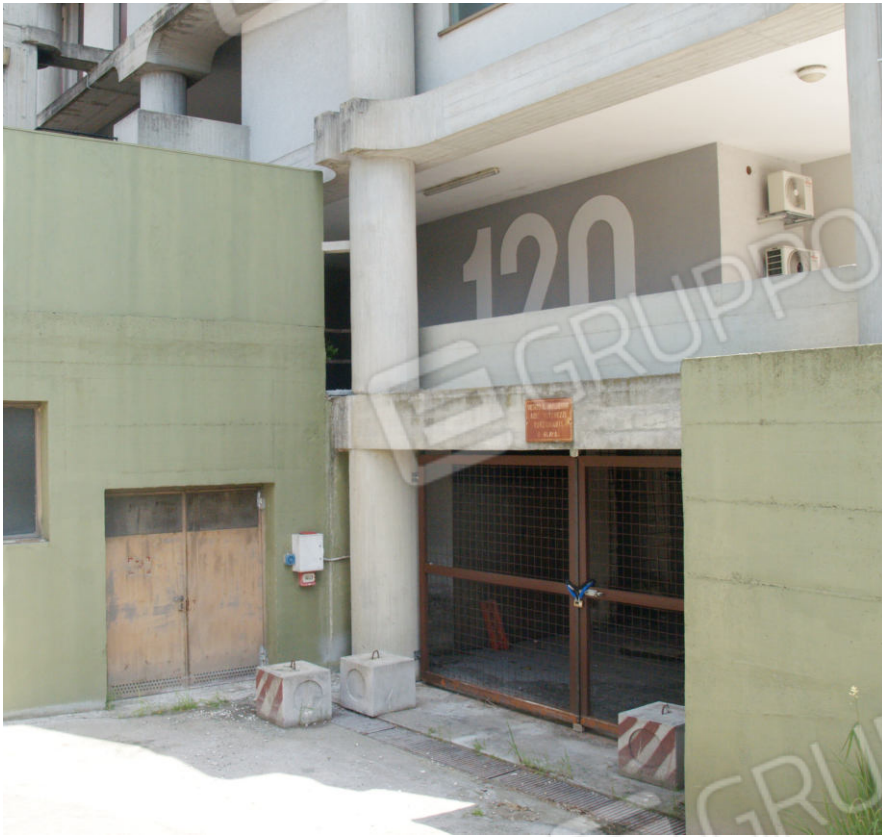
1. Ingresso comune al piano interrato
