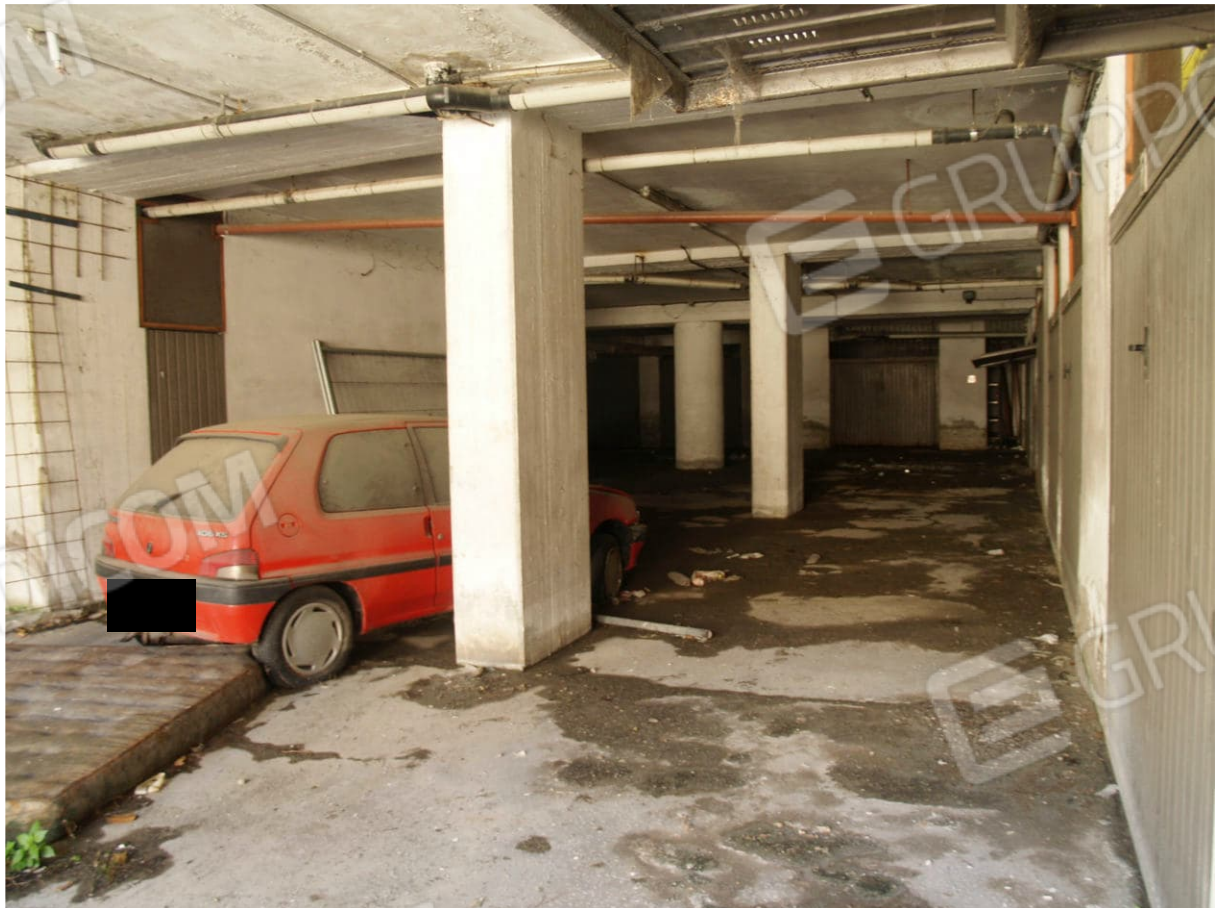
6. La corsia di manovra comune
