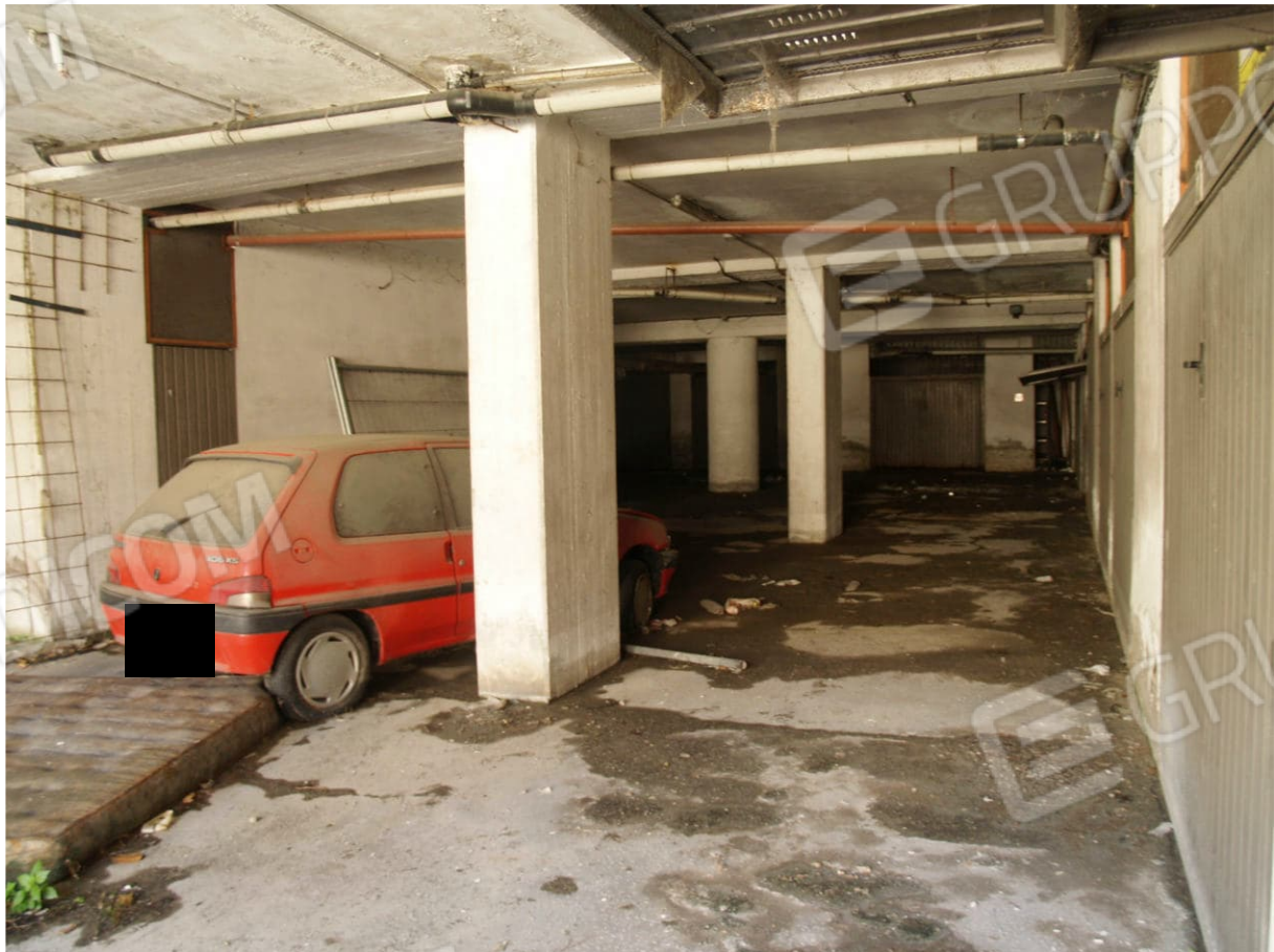
6. La corsia di manovra comune
