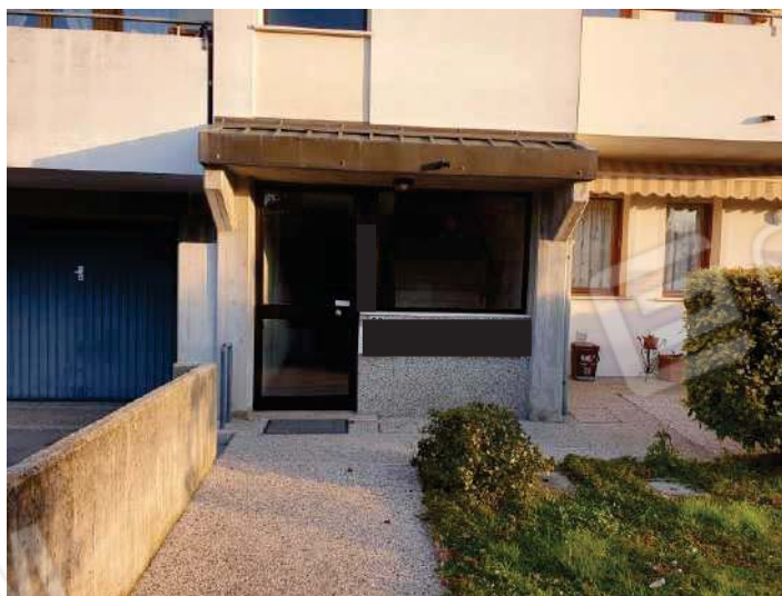
FOTO 3: vista vano scala esterno – lato sud
