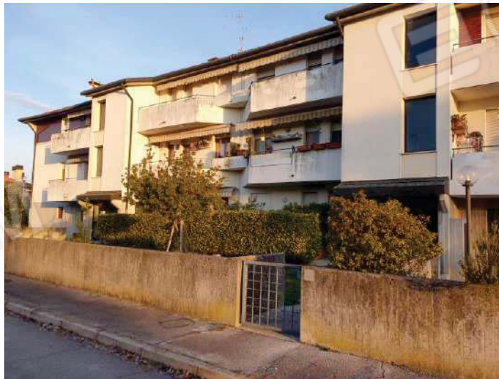
FOTO 1: vista lato sud
