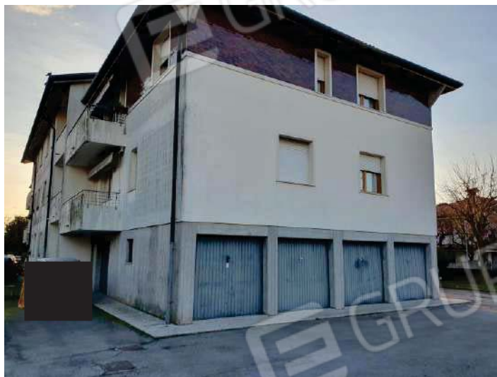
FOTO 2: vista lato ovest
