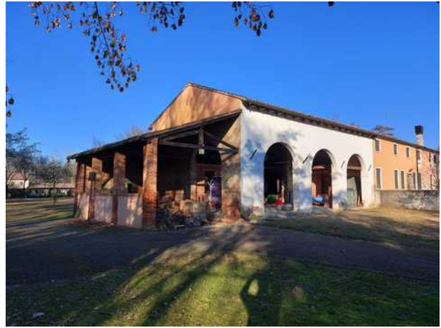
Veduta prospetto ovest-sud
