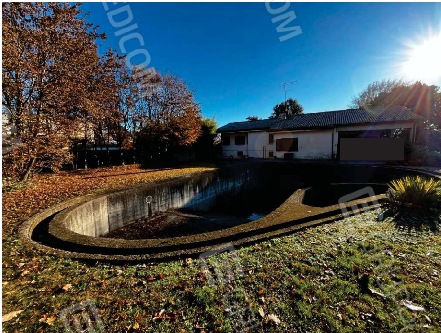
3. STRUTTURA "P" - vista verso il MN 247
