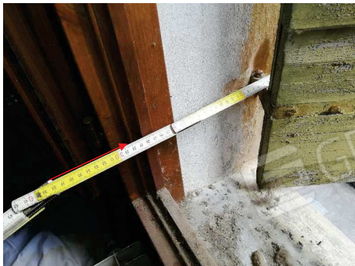
Foto 23. Particolare muri perimetrali
