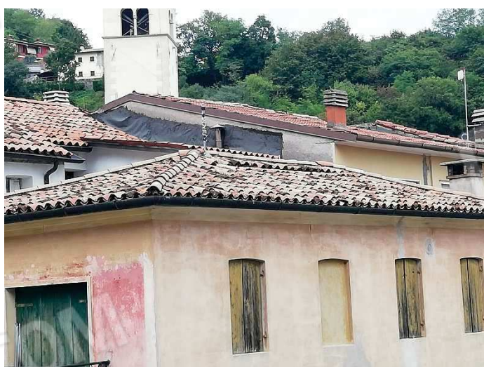
Foto 29. Vista copertura Sud - Ovest
