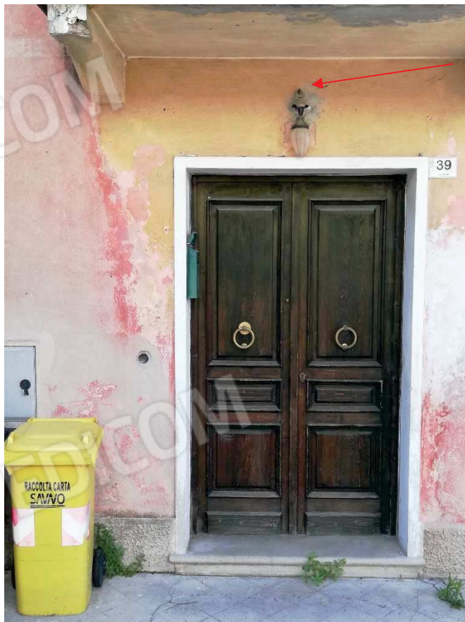
Foto 5. Vista Ovest - Ingresso
