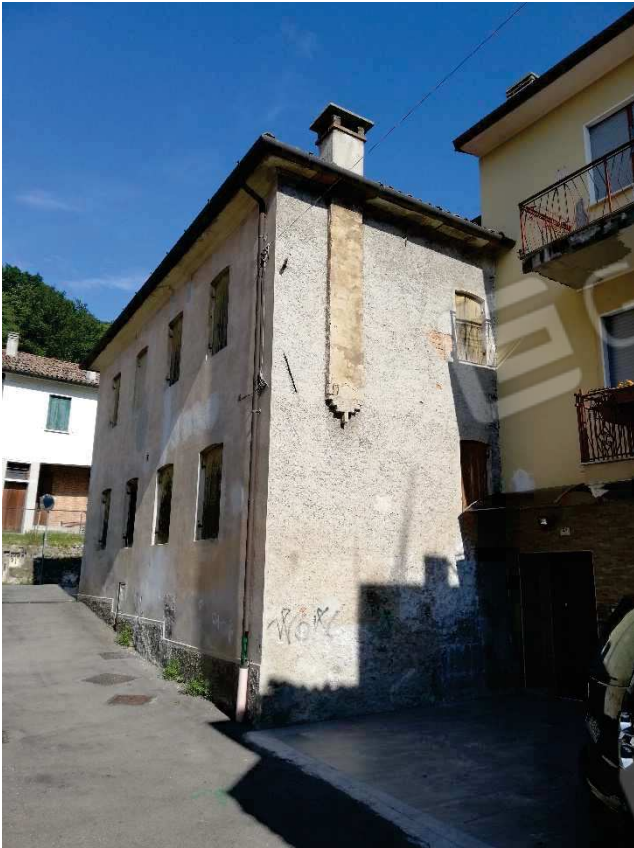
Foto 3. Vista Facciata Est
