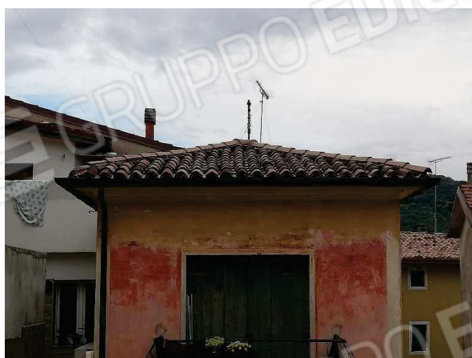
Foto 30. Vista copertura Ovest
