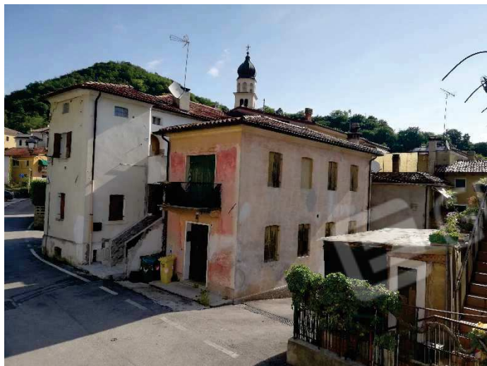
Foto 27. Vista Sud - Ovest
