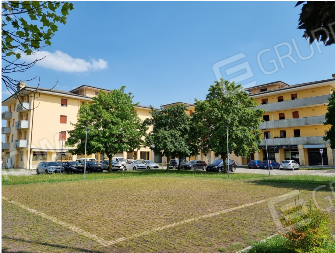
VISTA ESTERNA - FACCIATA GLOBALE NORD/OVEST
