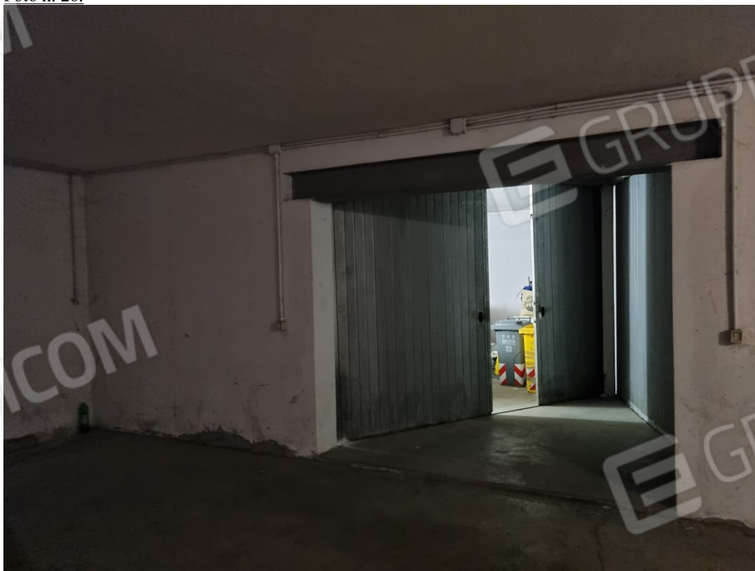
VISTA INTERNA - AUTORIMESSA
