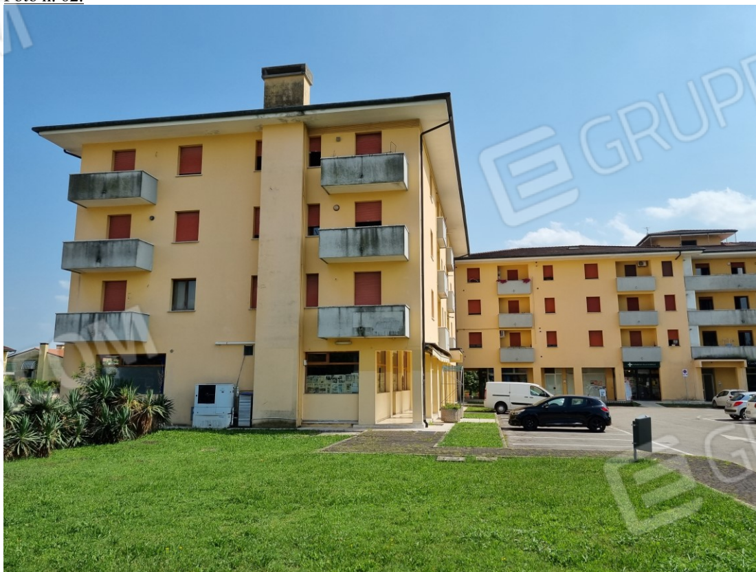
VISTA ESTERNA - FACCIATA NORD
