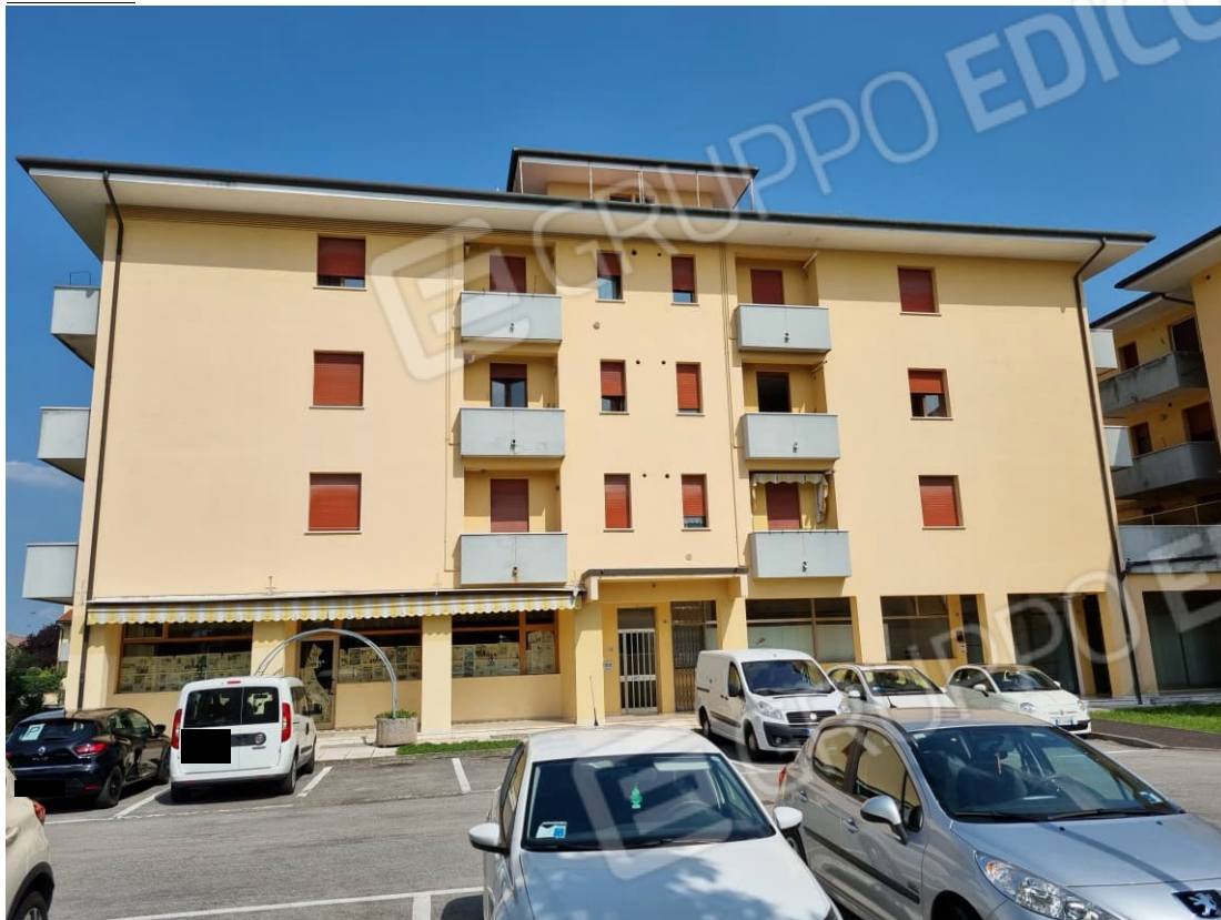
VISTA ESTERNA - FACCIATA OVEST
