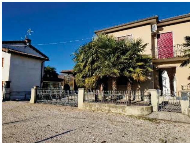
foto n. 1 abitazione - prospetto sud
