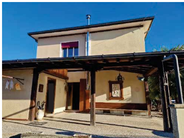
foto n. 2 – fabbricato abitativo - prospetto ovest
