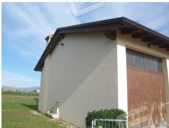
ANNESSO RUSTICO – LATO OVEST
