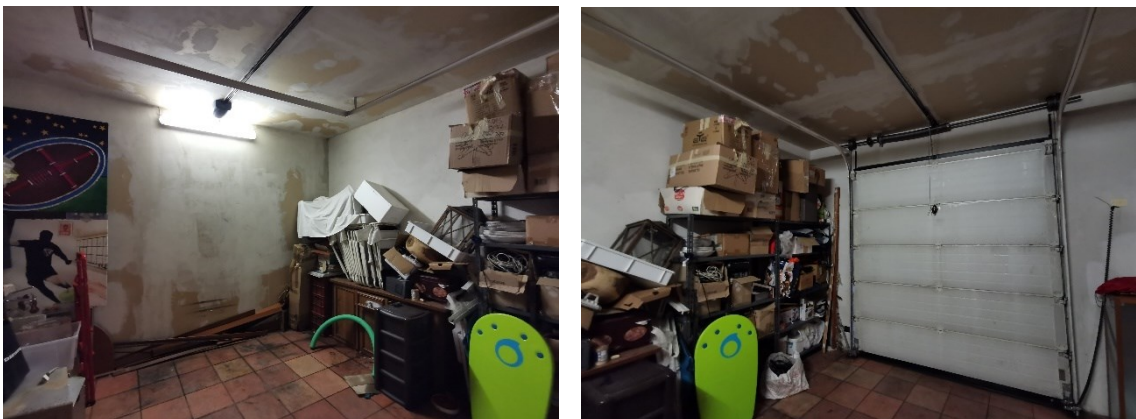
Fig. 19 – Panoramiche interne al garage
