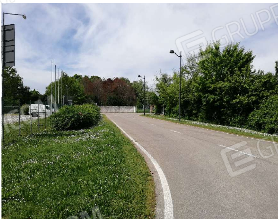
Fotografia n. 02 – Strada di accesso al lotto
