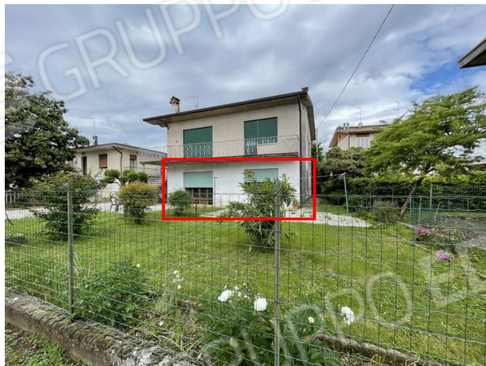
foto n. 4 – prospetto sud appartamento al PT e parte dell’area scoperta
