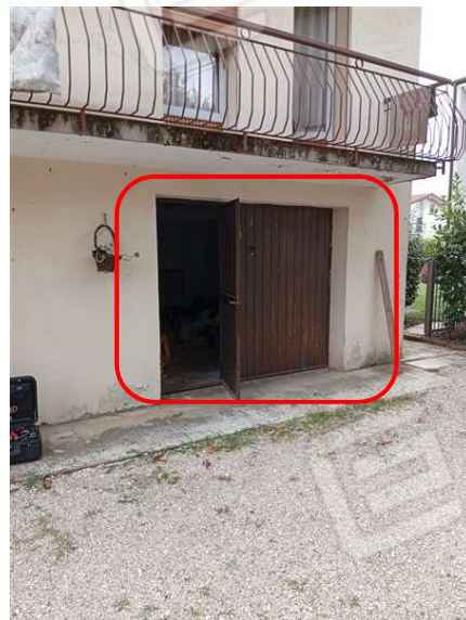
foto n. 18 – garage inserito nel fabbricato eretto nel m.n. 1112 del C.T.
