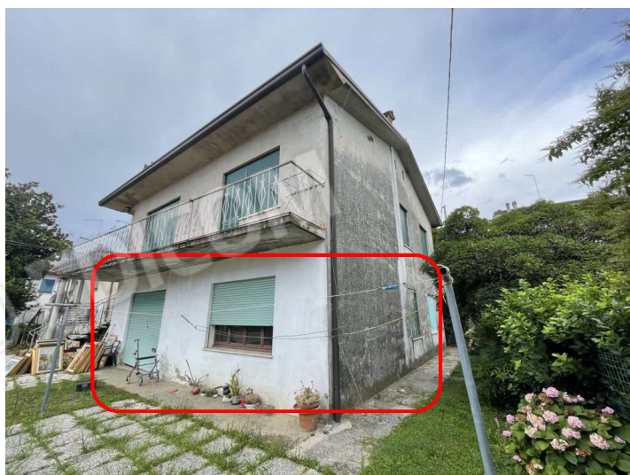
foto n. 5 – prospetti sud ed est
