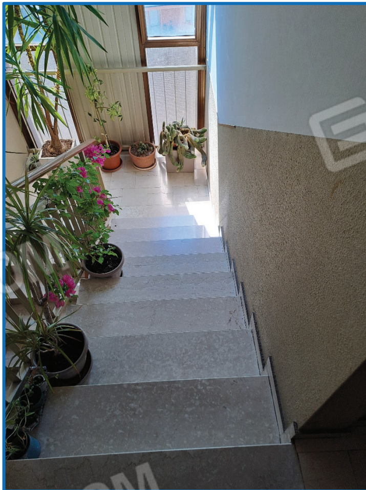
n° 4 Particolare scale condominiali
