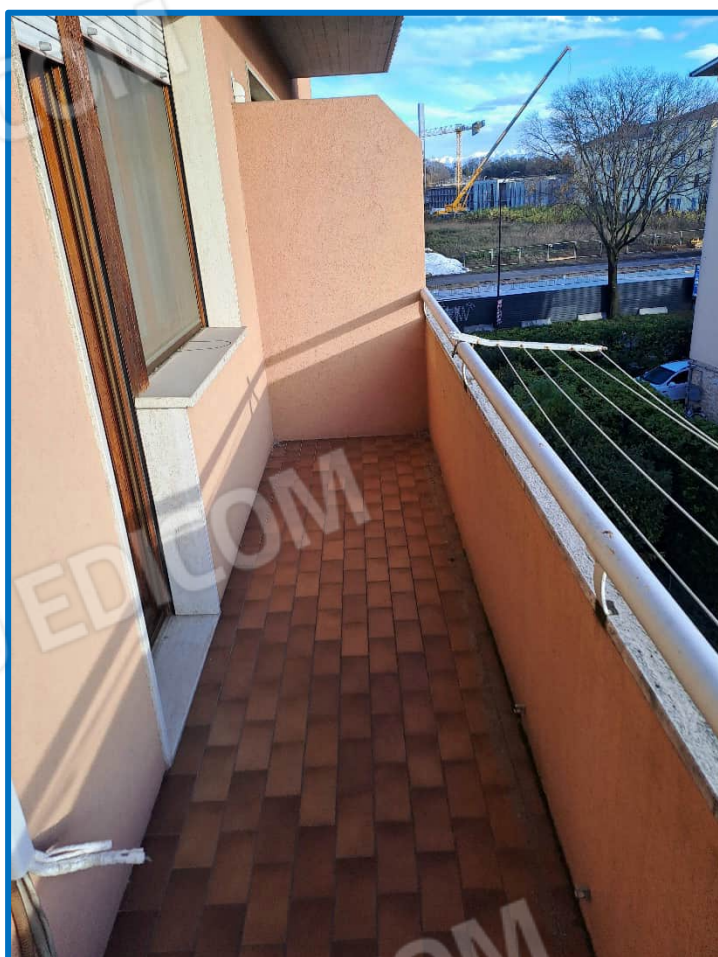
n° 16 – Particolare poggiolo est
