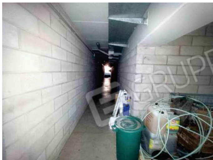
F36: P interrato corridoio comune
