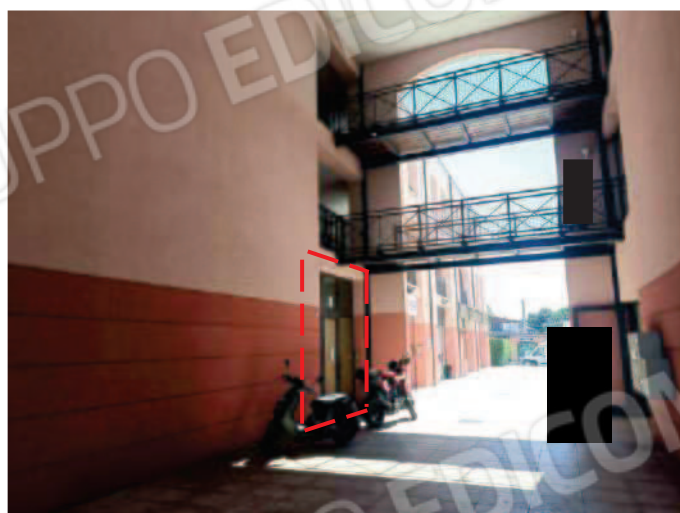
F02: ingresso da portico comune lato ovest
