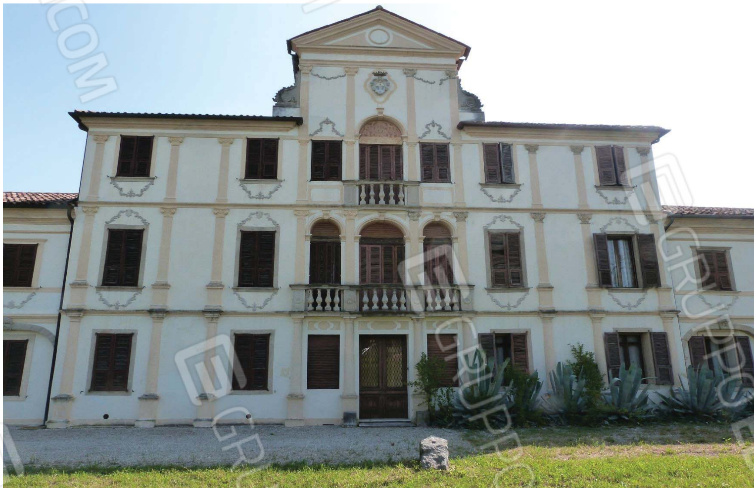
Vista del corpo centrale – prospetto principale.
